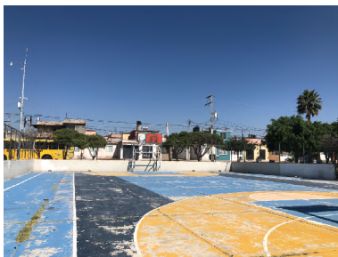
Imagen 8. Fotografías sitio. Fuente: Elaboración propia.
