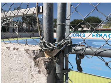
Imagen 7. Fotografías sitio. Fuente: Elaboración propia.
