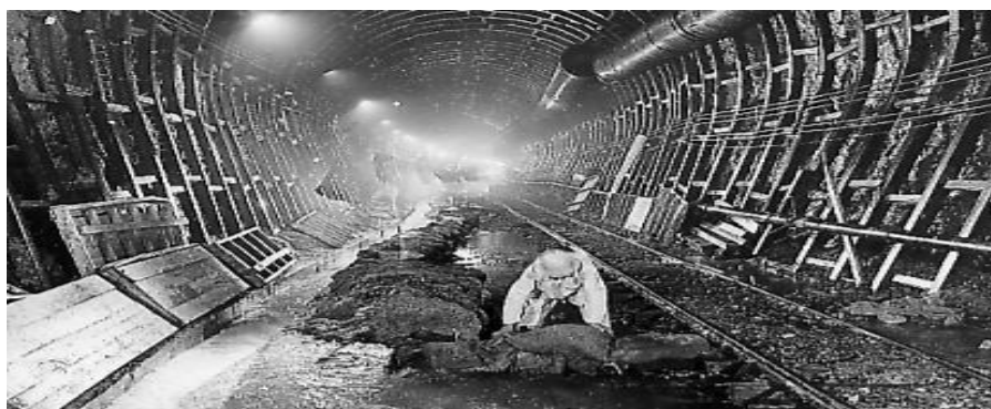
Figura 8 Construcción del Túnel Emisor Central (SACMEX, 2006)
