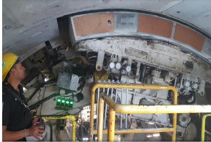
Figura 64 Colocación de dovelas en anillo 72 del TEO. (CONAGUA, 2012)
