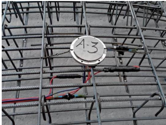
Figura 43 Celda de presión instalada en armado de dovola (ICA, 2012)
