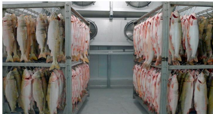
Figura 5. Congelador con flujo de aire por lotes (Moerman y Fikiin, 2016).
