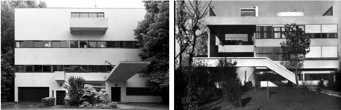
Imagen 31. Le Corbusier: Villa Stein en Garches, Francia. Fotos de las fachadas construidas.
