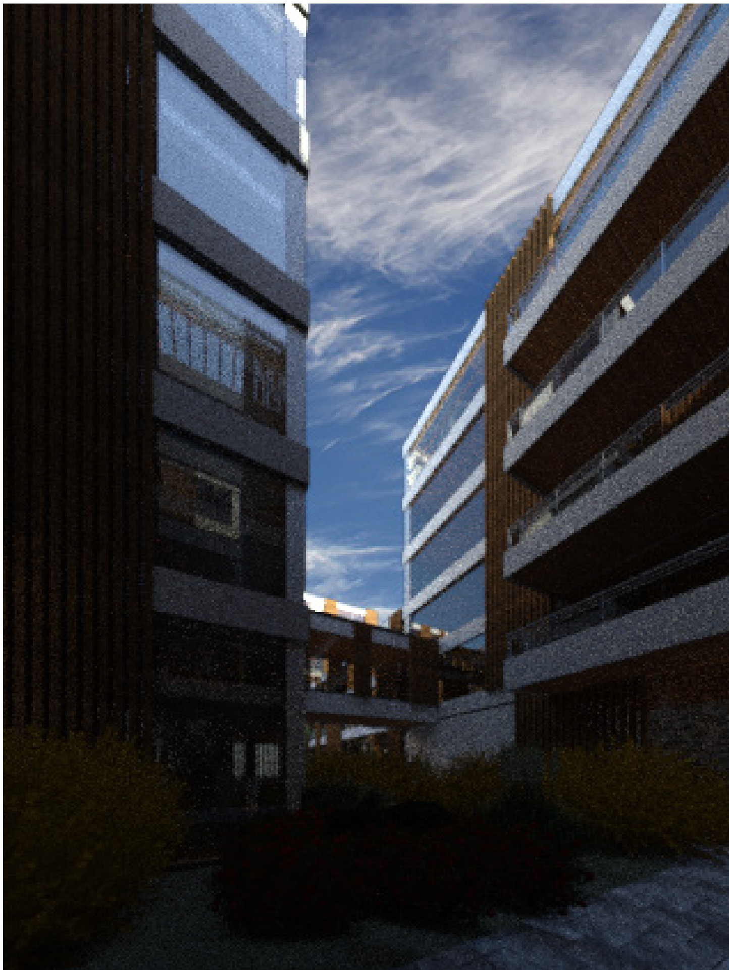
IMAGEN 134. Vista Patio Central desde Restaurante
