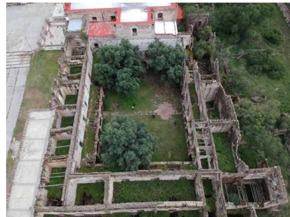
Ilustración 32. Vista aérea del estado actual de la ex hacienda. Fuente: Silvia Araceli Frausto Luján, 2018.
