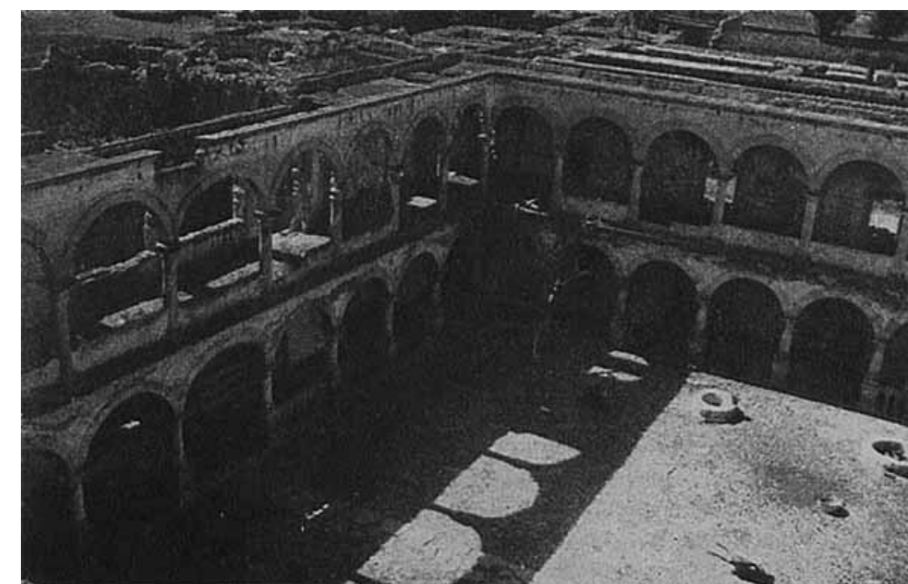
Ilustración 29. Vista aérea de patio central Fuente: Federico Sescosse
