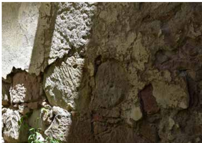
Ilustración 43. Vestigio de aplanado de cal arena, se propone la reintegración de la totalidad del muro con el mismo enlucido.
