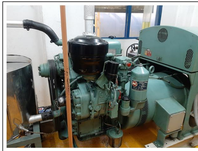
Figura 3.2 Conjunto generador, con motor GMC diésel, modelo 2150 (vista lateral izquierda)
