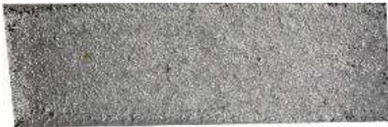
an-a 8.14 área afectada en la zona 5 (replica).
