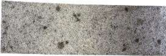
an-a 2.14 área afectada en la zona 5 (replica).
