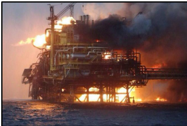
Ilustración 13: "Incendio en plataforma Abkatún-A 2015" – La Jornada.
