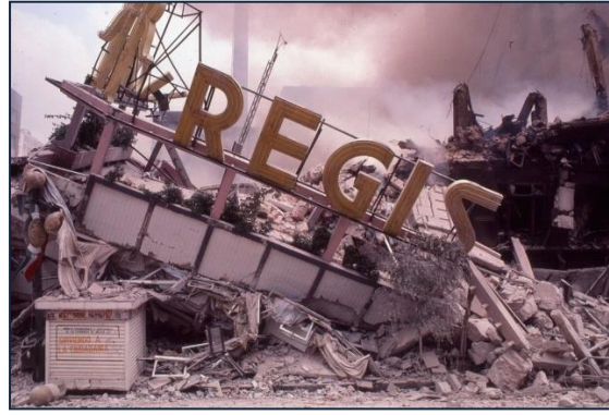
Fig. 16 Hotel Regis después del sismo Fuente: Proceso, 2015
