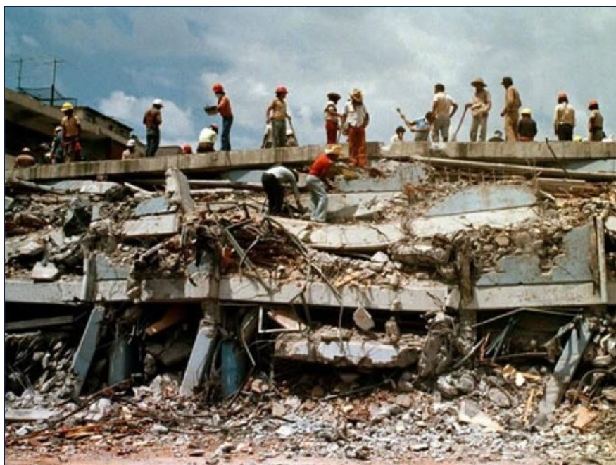
Fig. 15 Taller de Arquitectura colapsado Fuente: ERN, 2019
