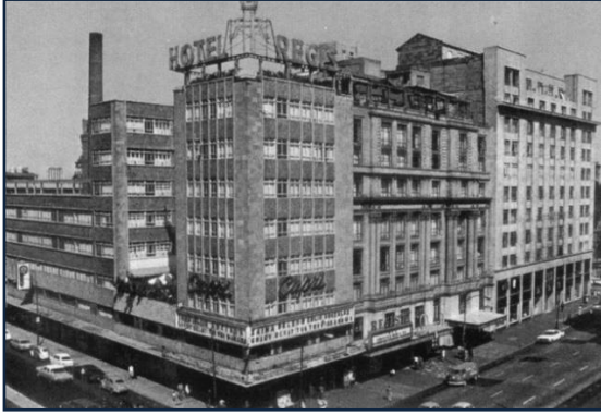
Fig. 17 Hotel Regis antes del sismo Fuente: Proceso, 2015
