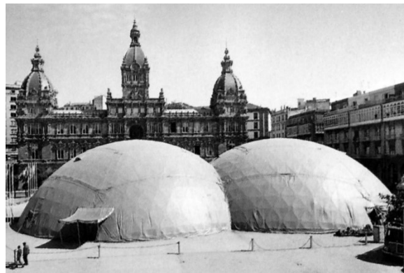
fig. 37: Fotografía del teatro de Festivales de España montado en A Coruña, ca.1966. Gran parte de las estructuras de Pérez Piñero se caracterizaron por ser desplegables y transportables . Fuente: Calvo López, José, Sanz Alarcón, Juan Pedro, Arquitectura plegable para una década prodigiosa. La obra de Emilio Pérez Piñero y la arquitectura de los años sesenta." EGA Expresión Gráfica Arquitectónica.16.17, 2011, pp:120 © Fundación Pérez Piñero
