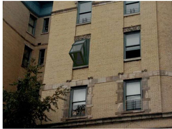
fig. 18: Ventanas plegables con distintas configuraciones que permiten acostarse sobre la misma, ver cenitalmente hacia el cielo o hacia abajo. Fuente: Santos, Sabrina. "¿No ves el cielo desde tu habitación? Con estas ventanas plegables sí podrás" 24 nov 2015. ArchDaily México. © Aldana Ferrer Garcia
