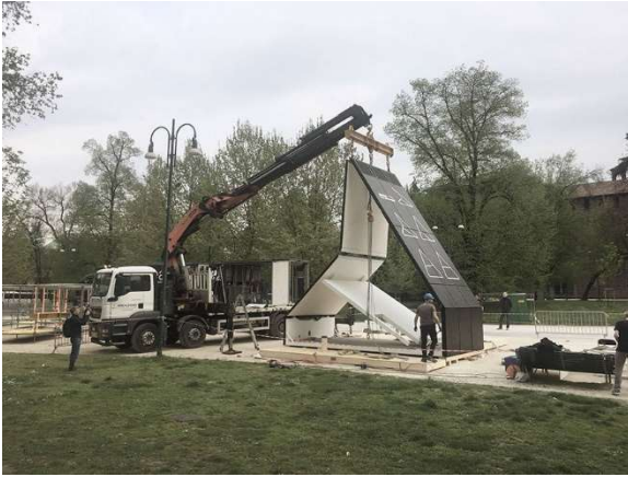
fig.30: Usualmente se nombra a esta casa como plegable, sin embargo, no todos sus componentes son plegables, solamente en este caso es el sistema constructivo/estructural que permite tener esta característica, prevista desde el proceso de diseño. Fuente: Ciclo, Vivo. "Arquitecto italiano proyecta casa plegable que se puede construir en 6 horas" 27 dic 2017. ArchDaily México. © M.A.Di./Divulgação, via CicloVivo
