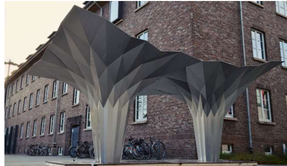
fig. 20: Un pabellón compuesto de paneles metálicos que han sido plegados conforme al mejor aprovechamiento del material y de acuerdo a un proceso de búsqueda formal realizado con un software de diseño. Fuente: Lynch, Patrick. "Este pabellón originami crea un refugio con 8 láminas plegables de aluminio" 25 feb 2016. ArchDaily México. © Tal Friedman
