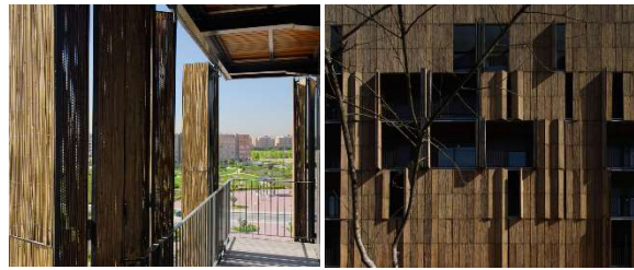
fig. 35: Los elementos plegables son louvers de bambú, los cuales componen las fachadas de este edificio de viviendas, permiten controlar el grado de iluminación y ventilación hacia el departamento y al pasillo general. Fuente: "Carabanchel Housing / Foreign Office Architects" 30 May 2008. ArchDaily. Accedido 24 Mar 2020. © Foreign Office Architects
