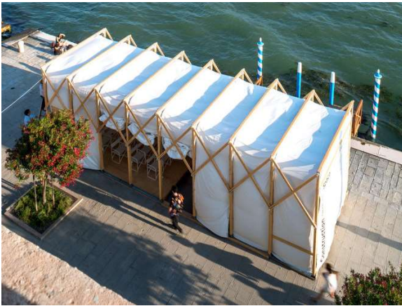
fig. 32: El cine plegable, se compone de distintos elementos, una estructura articulada que permite ser plegada, así como una membrana textil flexible que puede acompañar el despliegue de la estructura. Fuente: Forde, Tessa. "Pop-In, Pop-Out, Pop-Up: Un cine callejero plegable para Venecia" 18 oct 2017. ArchDaily México. © Nicolò Zanatta / Omri Revesz Design Studio
