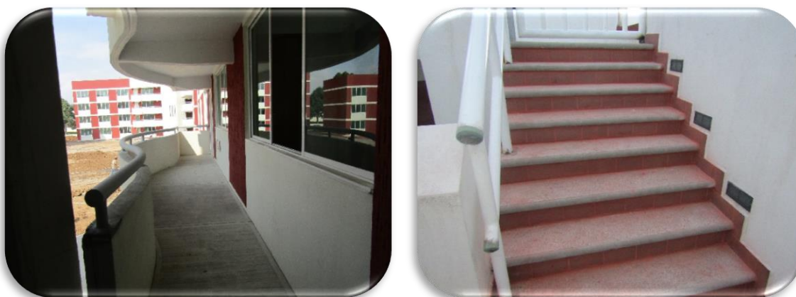
Foto 1.14 Pasamanos en escaleras y pasillos, Residencia de Obra.
