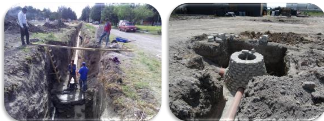
Foto 1.16 Pozo de visita y tubería en Red Sanitaria, Residencia de Obra.
