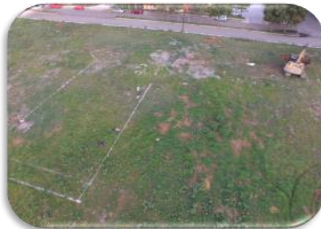
Foto 1.3 Vista aérea de Trazo de Edificio T-120200, Residencia de Obra.
