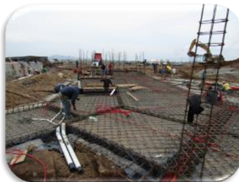
Foto 1.9 Colocación de tubería para instalaciones, Residencia de Obra.
