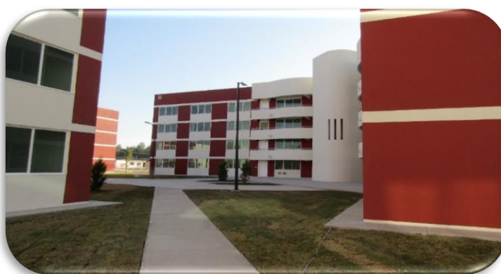
Foto 1.20 Jardinería colocada en Unidad Habitacional, Residencia de Obra.
