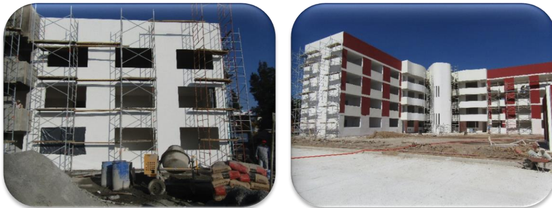
Foto 1.13 Vista frontal de acabados en Edificio, Residencia de Obra.
