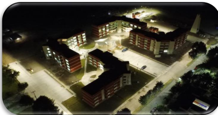
Foto 1.17 Vista aérea de Alumbrado Público, Residencia de Obra.
