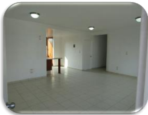
Foto 1.10 Colocación de luminarias en departamentos, Residencia de Obra.
