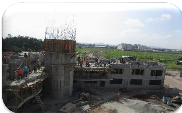
Foto 1.8 Vista frontal de estructura hasta primer nivel de Edificio T-160200, Residencia de Obra.
