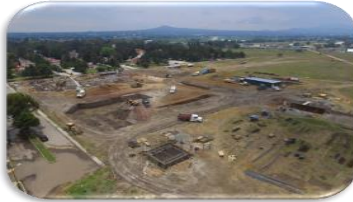
Foto 1.4 Vista aérea de Movimiento de Tierras, Residencia de Obra.
