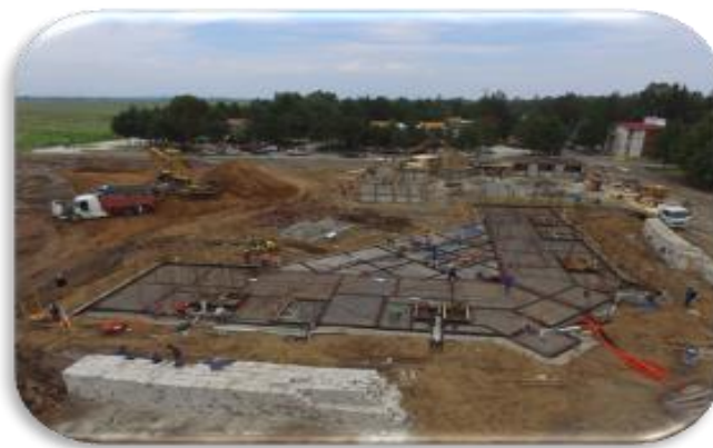
Foto 1.5 Vista aérea de Cimentación en Edificio T-120200, Residencia de Obra.
