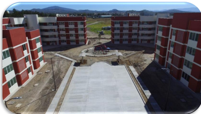
Foto 1.19 Vista aérea de Vialidad en unidad habitacional, Residencia de Obra.
