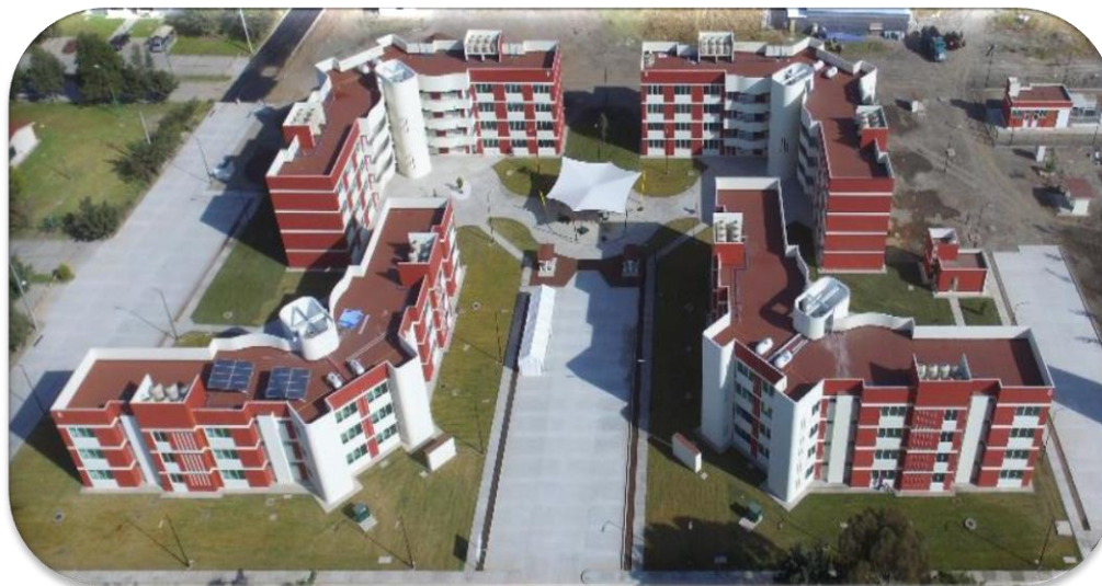
Foto 1.2 Vista aérea de la Unidad Habitacional, Residencia de Obra.
