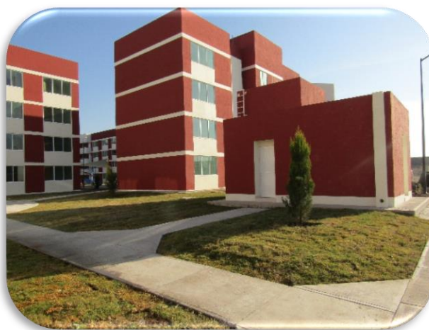
Foto 1.22 Vista lateral de Administración, Residencia de Obra.
