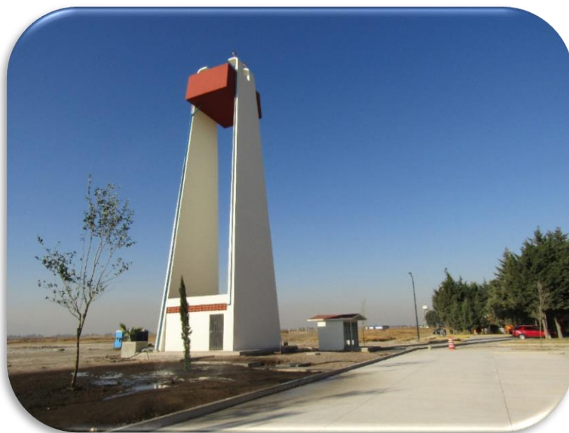
Foto 1.21 Vista frontal de Tanque Elevado, Residencia de Obra.
