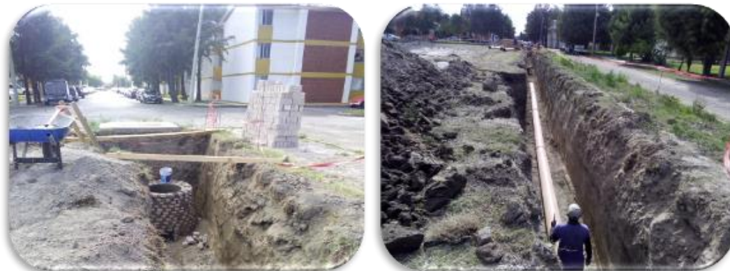
Foto 1.15 Pozo de visita y tubería en Red Sanitaria, Residencia de Obra.
