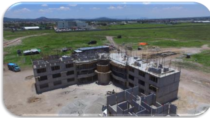
Foto 1.7 Vista aérea de estructura hasta segundo nivel de Edificio T-120200, Residencia de Obra.
