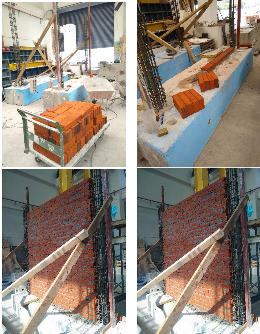
Figura 26. Construcción de los especímenes.
