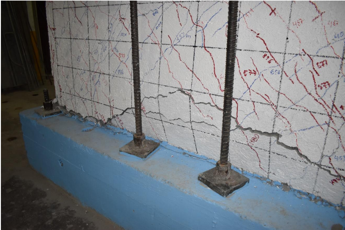
Figura 132. M-2R a \delta = 0.01 . Grieta pico: 1.25 mm, grieta residual: 0.35 mm.
