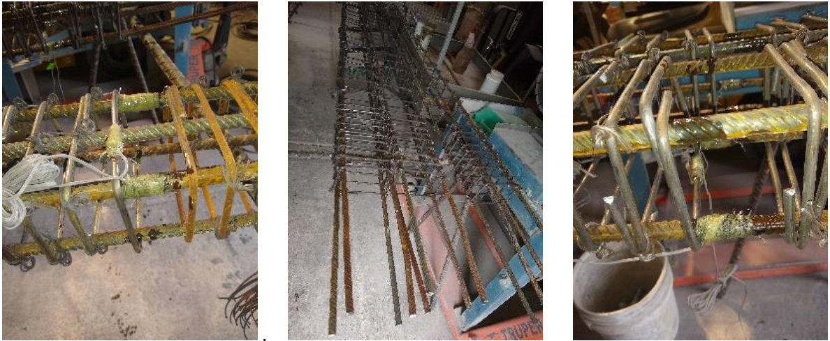
Figura 18 Instrumentación del acero de refuerzo de los castillos.
