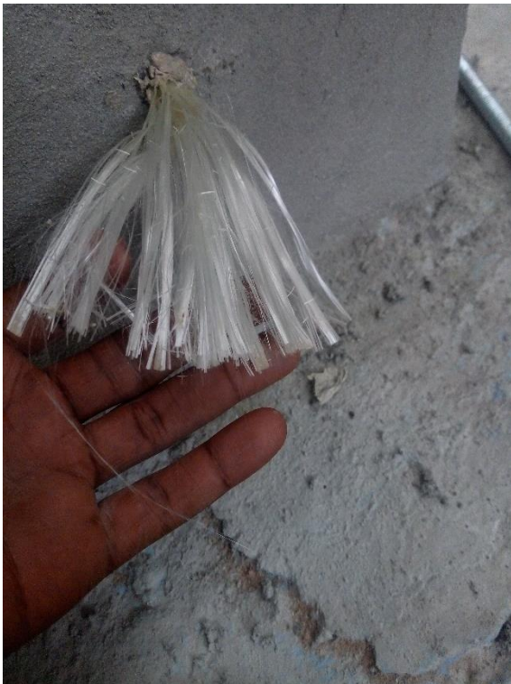
Figura 36. Anclaje del aplanado con fibra de vidrio.
