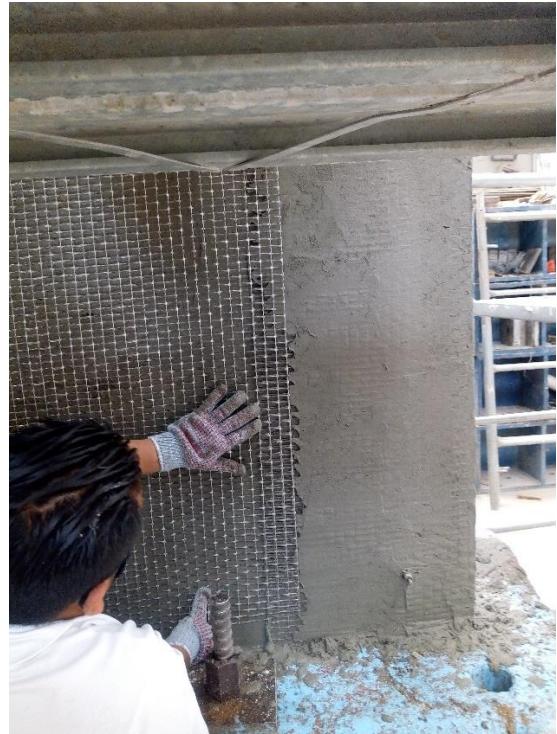
Figura 35. Aplicación de la malla de fibra de vidrio con mortero industrializado (Sika).
