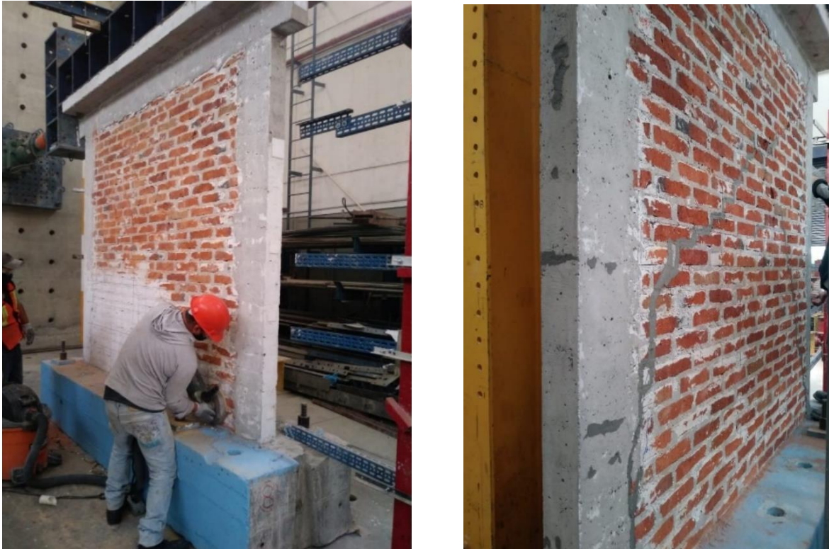
Figura 34. Preparación del muro para la rehabilitación.
