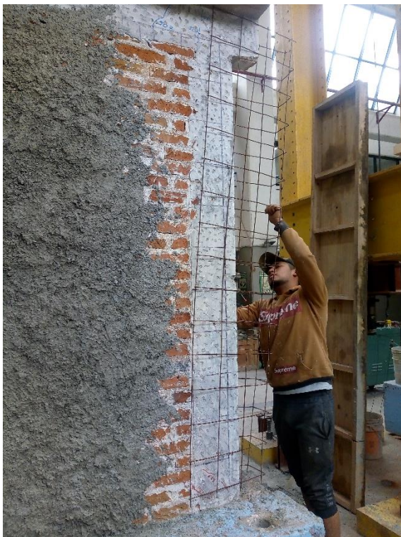
Figura 33. Muro rehabilitado con fibra.
