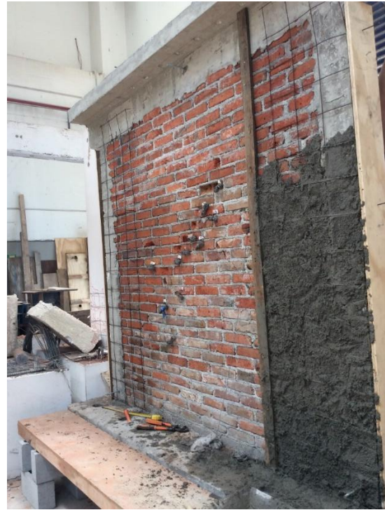
Figura 30. Aplicación de la malla (solo en las esquinas) de la cara no rehabilitada.
