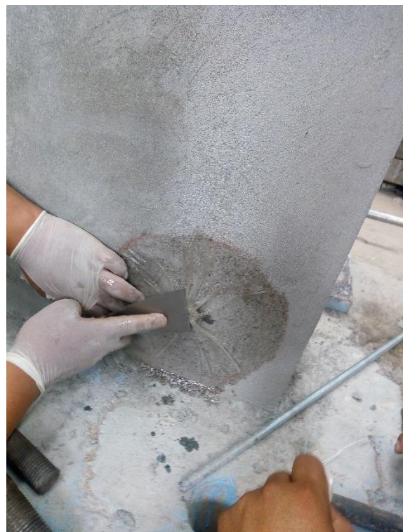
Figura 36. Anclaje del aplanado con fibra de vidrio.
