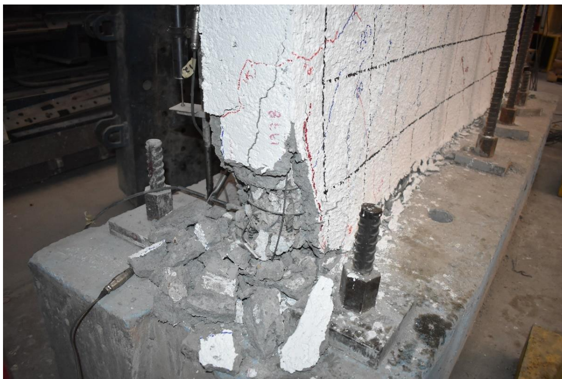
Figura 127. M-1R a \delta = 0.010 . Grieta pico: 1.6 mm, grieta residual: 0.6 mm.
