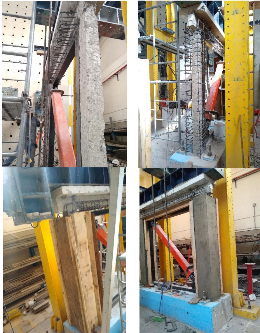
Figura 39. Rehabilitación del marco de M-10 con encamisado.
