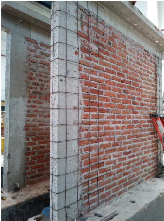
Figura 30. Aplicación de la malla (solo en las esquinas) de la cara no rehabilitada.
