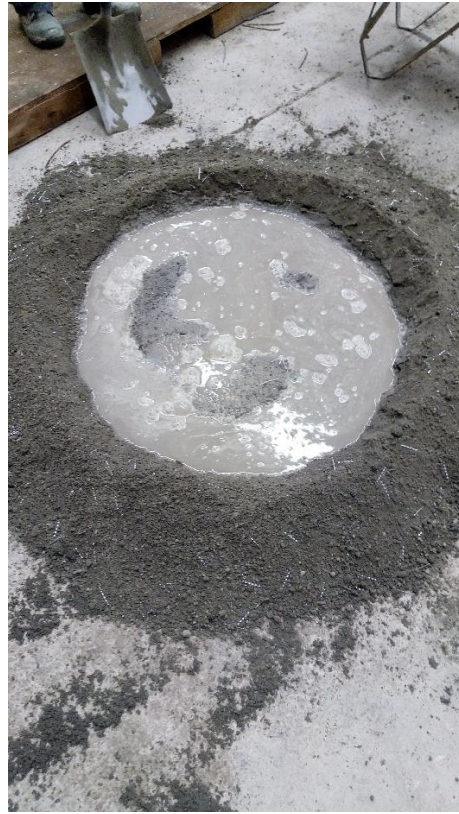
Figura 32. Mezclado del mortero con la fibra.
