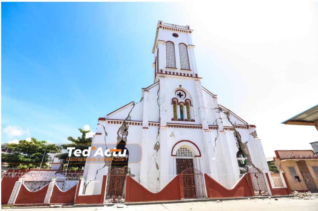
Figura 3. Daños en la iglesia “Le Sacré-Coeur de Jésus” en el sismo de Haití del 14/ago/2021 (Créditos: Ted’Actu).
