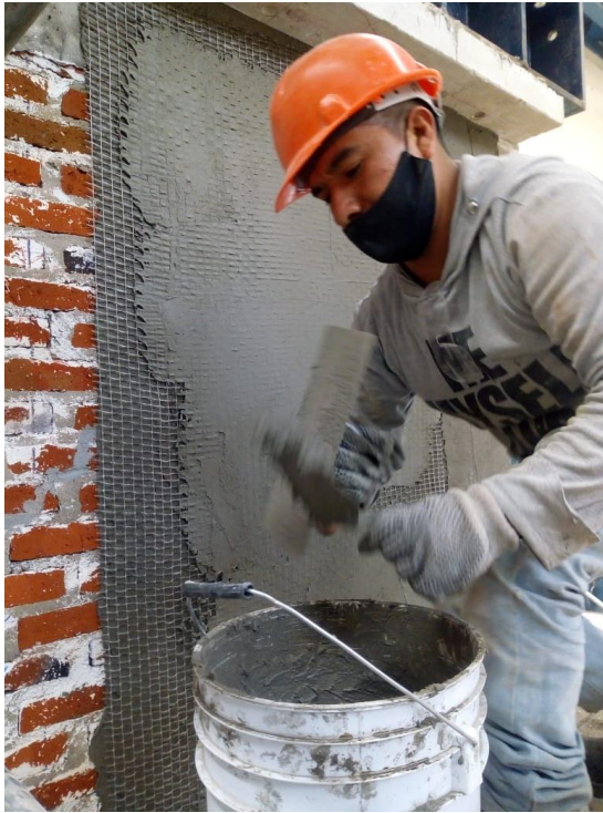
Figura 35. Aplicación de la malla de fibra de vidrio con mortero industrializado (Sika).
