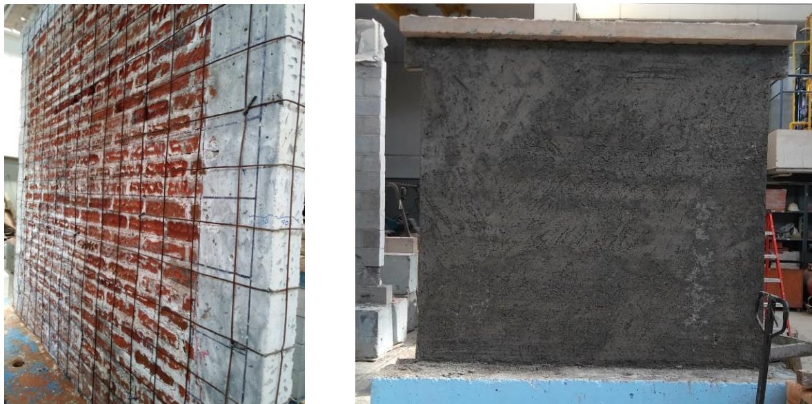
Figura 29. Aplicación de la malla completamente en la cara rehabilitada.
