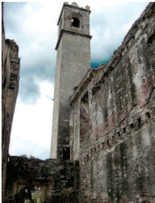
Torre del Campanario
