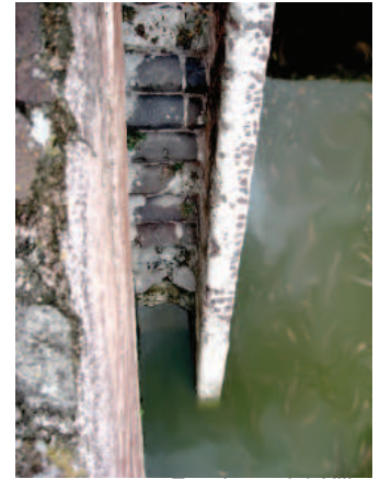
Escaleras del Aljibe
