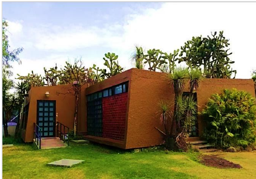
Fig. 1. Edificio que alberga la Azotea Verde Extensiva (EGR). Jardín Botánico-Instituto de Biología, UNAM
