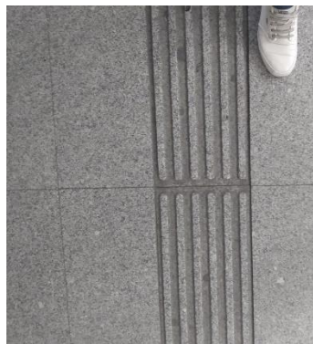
Baldosas táctiles dentro de la zona de Fórum Buenavista.
