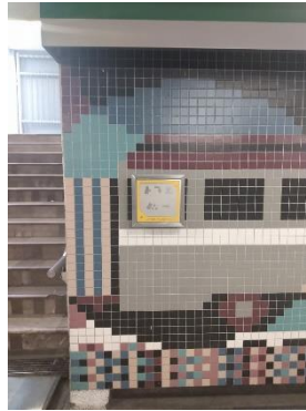
"Ayuda a los ciegos". Sobre muro; no se encuentra bien referenciado por las guías táctiles en suelo.
