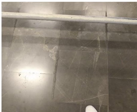
Detalle en "Zig-Zag" con líneas de concreto que sobresalen en las baldosas; debido a su desgaste son casi imperceptibles a un nivel visual y táctil.
