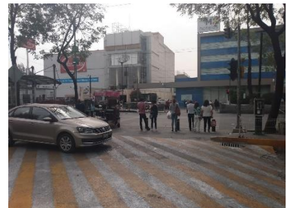
Sin señalización de cruce peatonal, sin uso de rejillas pluviales y baldosas de cambio de suelo.
