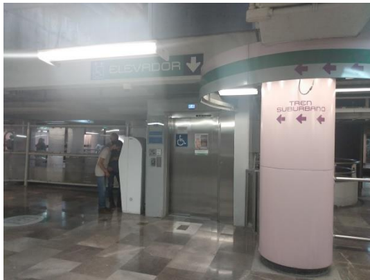
Falta de "ruta táctil" hacia el elevador, falta de correcta señalización de tren suburbano.
