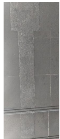
Detalle de baldosa táctil sobre escalinata.
