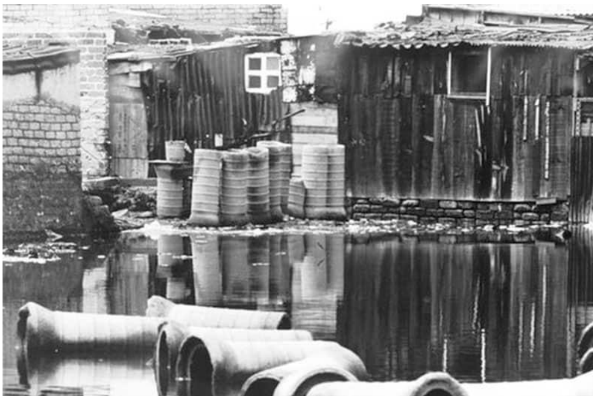
Imagen 17 Construcciones y tuberías
