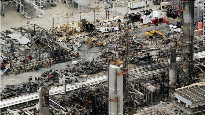
Fig. 1.1 Explosión en refinería de BP en la unidad de proceso de isomerización localizada en Texas, USA. La onda expansiva arrasó con todo a su paso en un área de 19,000 m<sup>2</sup>.
