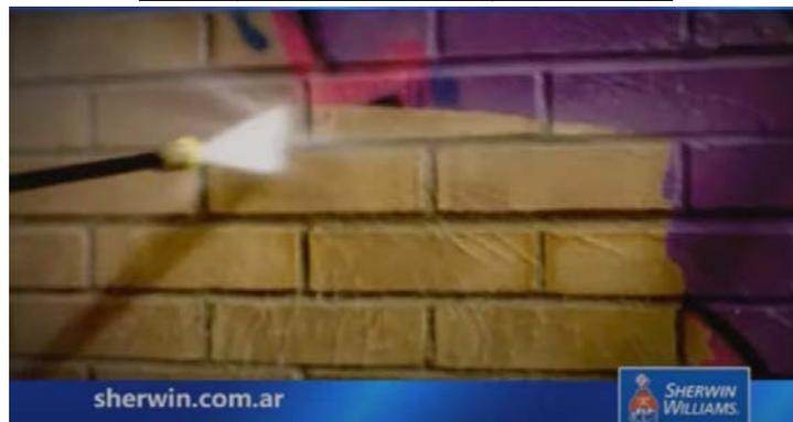
Figura 2.14 Acabado de un recubrimiento antigrafiti de sacrificio.
