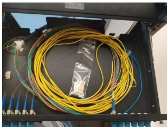
*Figura 4.2 Distribuidor y panel de conectores del Aula de UNAM Mobile.*
