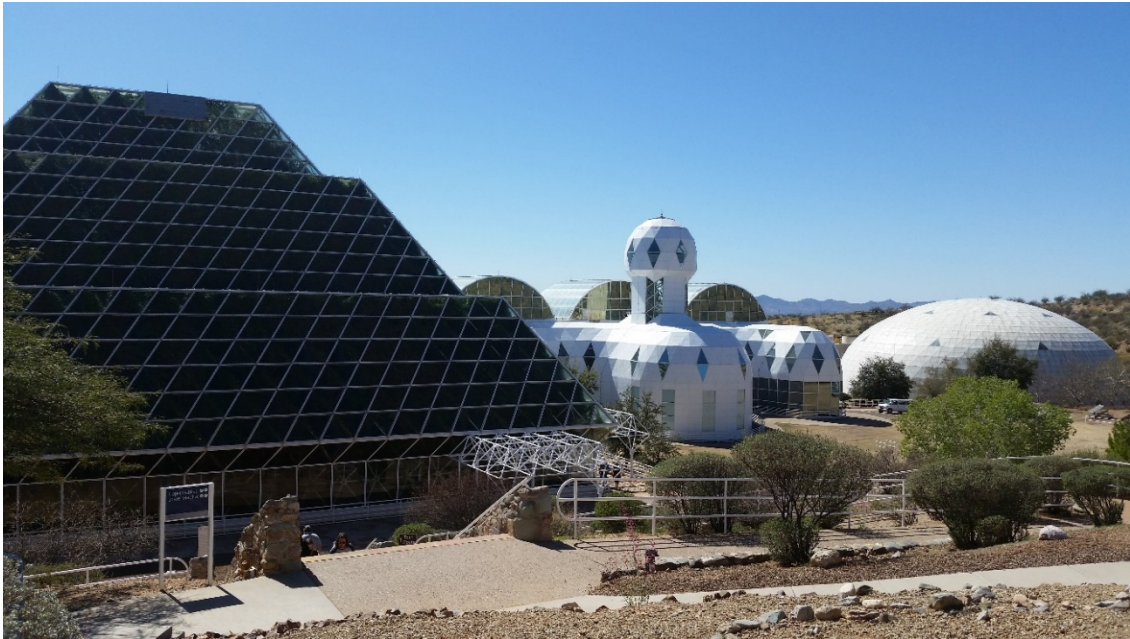
Figura 9. La Biosphere 2. En la fotografía se observan los domos que albergan los ecosistemas de selva y el humano, así como uno de los “pulmones” que posibilitan el reciclaje del aire en el complejo. Fotografía obtenida de Flickr (Frost Museum), “Blog4AAA2016-02-26 13.01.05”, con licencia CC BY 2.0.
