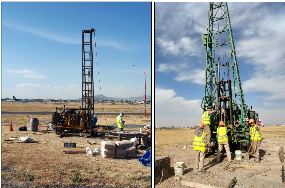
Figura 17 Ejecución de sondeos mixtos SM-02 y SM-03.
