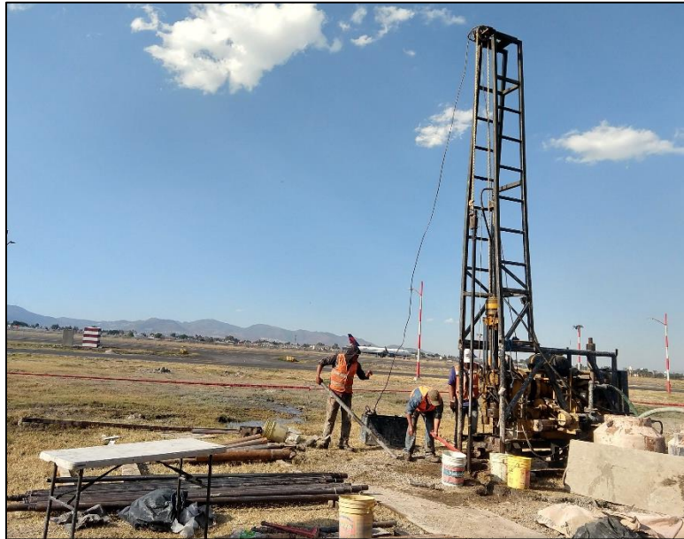
Figura 21 Ejecución del Piezómetro de cuerda vibrante (SCV-01).
