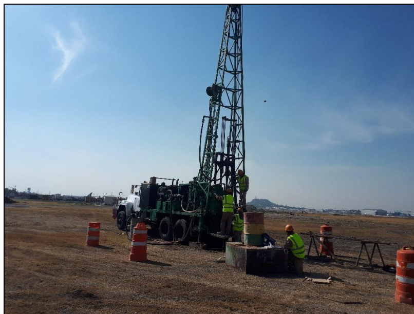
Figura 19 Ejecución de Sondeo de Cono Eléctrico (SCE-01).
