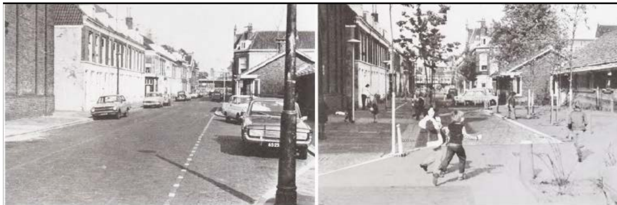
La misma calle en Holanda en modificación de su estructura. Antes Después del proyecto "Woonerf" Imágenes del libro "Leben zwischen Häusern" (Vivier entre casas) de Jan Gehl, 1971
