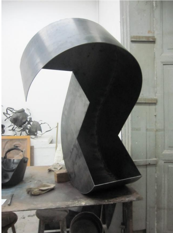
Fig. 81 Piezas de Cóatl unidas mediante soldadura de arco eléctrico. Ya se aprecian las primeras formas de la escultura que se construye a base de módulos separados que se irán uniendo progresivamente.
