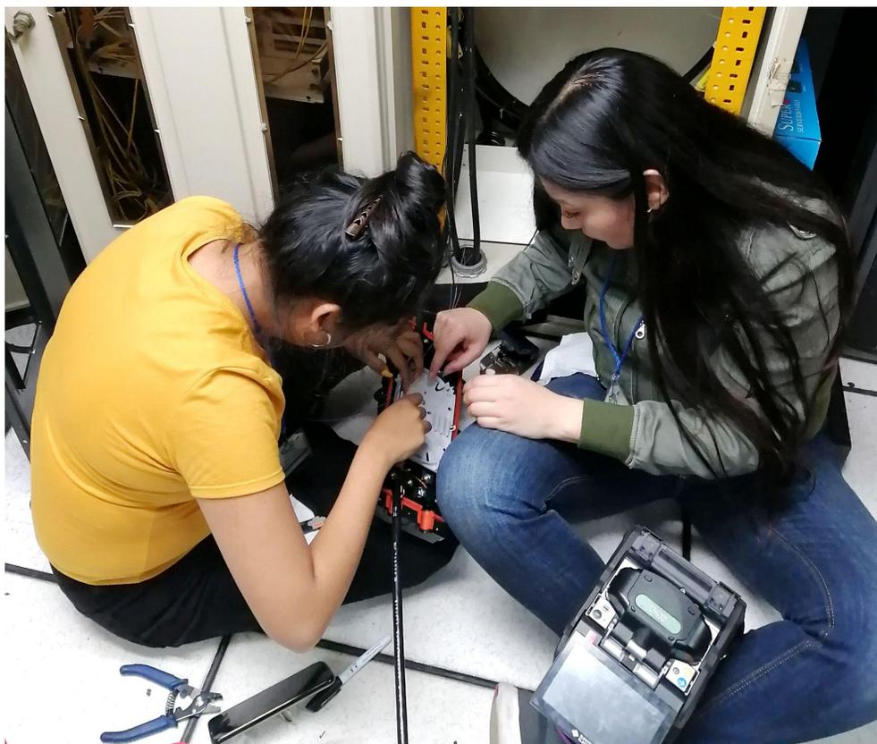
*Figura 3.16. Instalación de caja de empalme sitio 25.*
