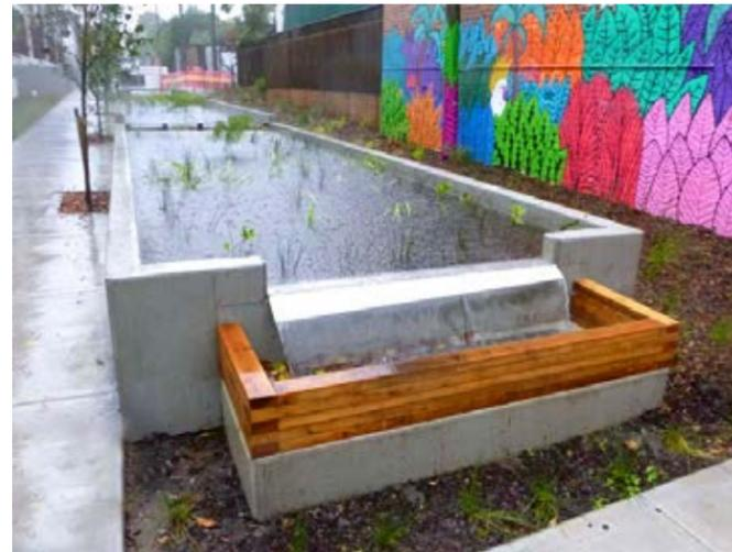
Fig. 4.24. Jardinera de biorretención sobre el nivel de banqueta.
