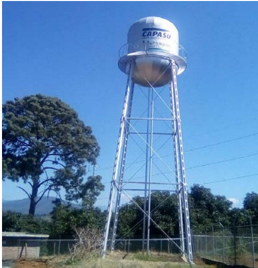
Fotografía 3.1.- Tanque de agua
