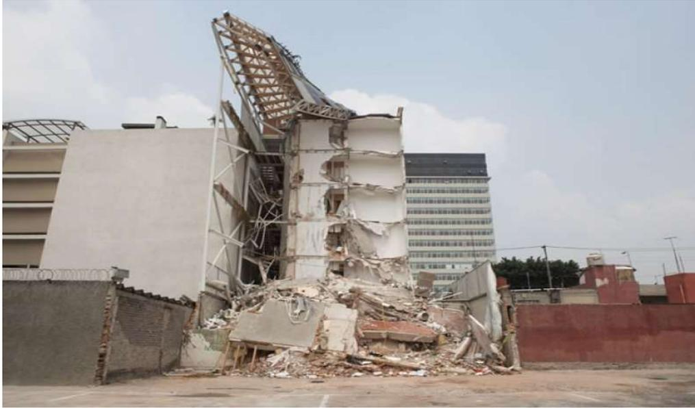
Figura 17. Edificio demolido debido a los daños estructurales después del sismo del 19 de septiembre del 2017 en la CDMX.
