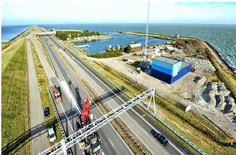
Figura 3. Planta de energía del gradiente salino por la técnica RED ubicada en los Países Bajos.
