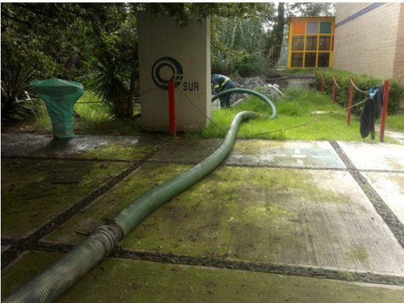
Fotos A.2.10. Camión tipo “vactor” realizando el desazolve de los lodos de la fosa séptica FS-101
