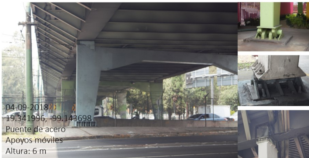
Figura 32. Trabajo de campo realizado para la caracterización de puentes en el área de estudio
