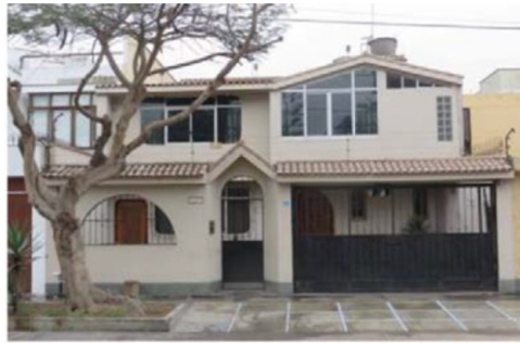
Figura 24. Edificio de mampostería con confinamiento típico de acuerdo con la clasificación de Yepes-Estrada et al. (2017)
