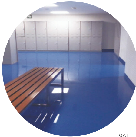
[96] Piso epóxico para zonas de servicio: Enfermería, Sanitarios, Regaderas Laboratorios, Cocina.
