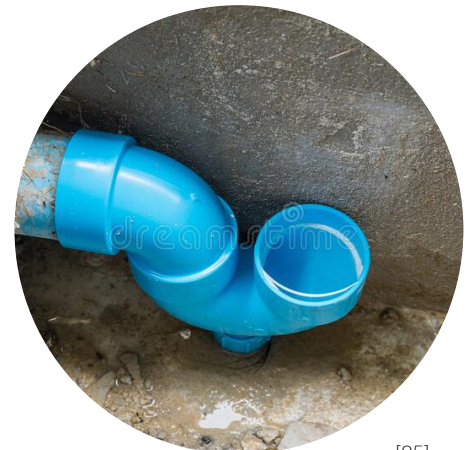
Empleo de trampas de olores por núcleo sanitario
