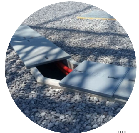
Trincheras pre fabricadas para Inst eléctrica
