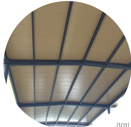
Multipanel + estructura metálica
