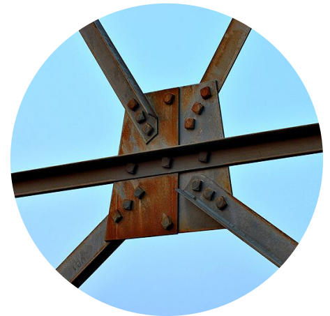
Estructura metálica de alama abierta unido por placas
