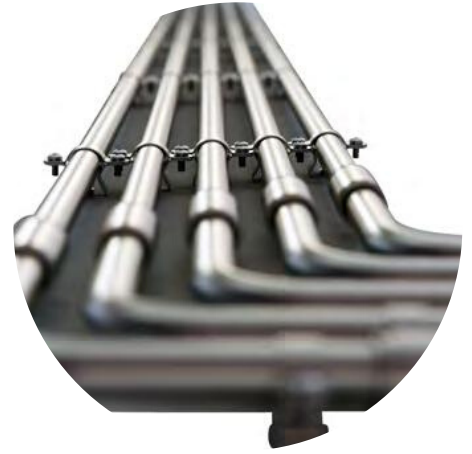
[94] Instalación eléctrica aparente
