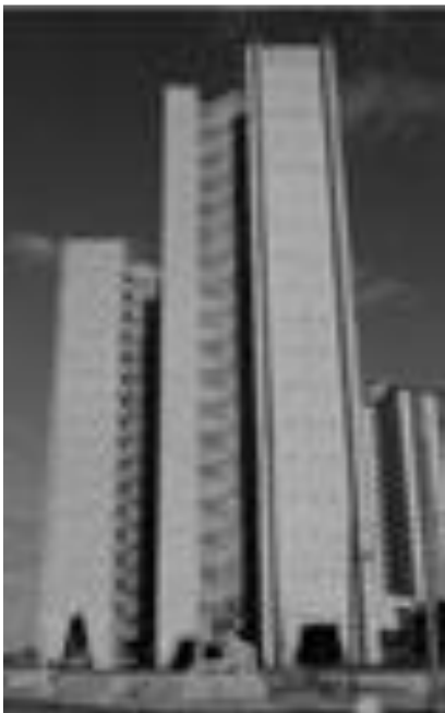
EDIFICIO DE 17 PLANTAS. A. QUINTANA, A. RODRÍGUEZ Y OTROS, 1967. Fuente: (Méndez, 2010)
