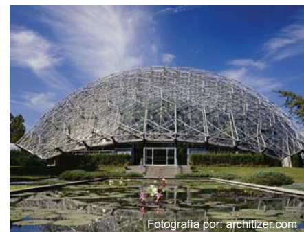
Fotografía por: architizer.com 48 Climatron, St. Louis architects Murphy and Mackey. 1960
