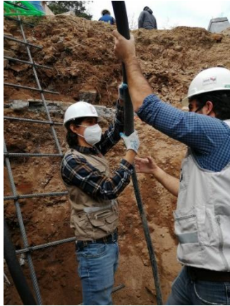
(c) Colocación del aislante térmico
