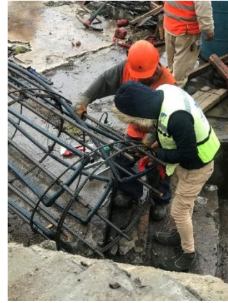
(b) Colocación de los codos en forma de U
