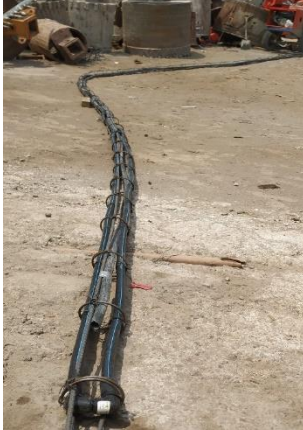
(e) Armado con tubería tipo PEAD
