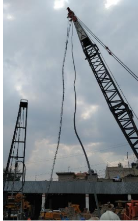
(c) Izaje del armado rígido
