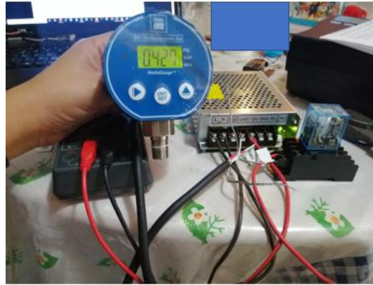
(b) Conexión de los manómetros de prueba para medir la presión
