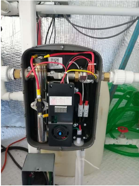
(g) Interior del calentador eléctrico
