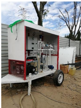
(a) Llegada del equipo a la obra
