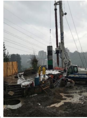
(b) Colación de la tubería de revestimiento
