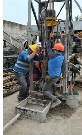
(d) Colocación del armado en el pozo
