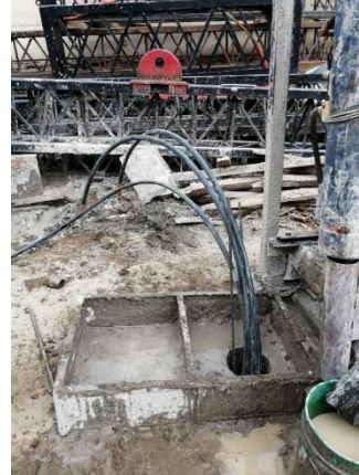
(f) Pozo con tubería tipo PEAD
