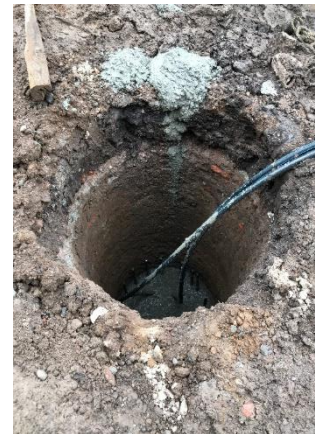
(f) Pila de energía con tuberías sobresalientes para conexión
