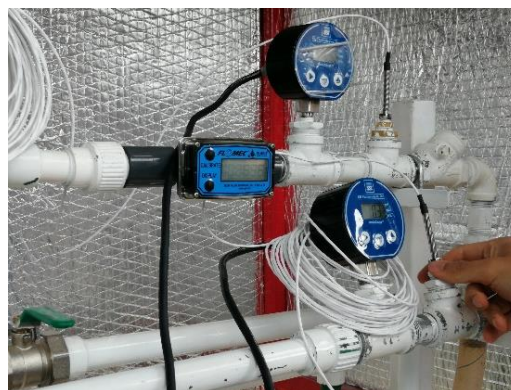
(b) Colocación manómetros de presión y sensores Pt 100
