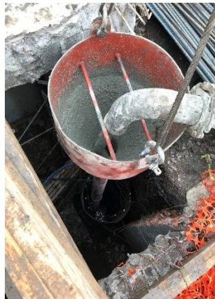
(e) Colocación del material de relleno en la perforación
