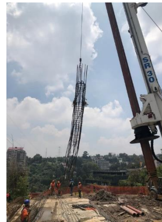
(d) Izaje del armado rígido y las tuberías PEAD
