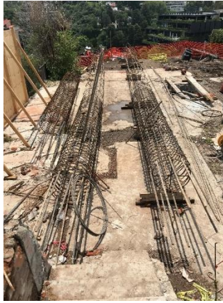
(a) Armado rígido de la pila de energía
