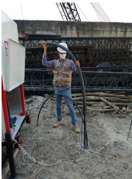
(a) Colocación del polietileno expandido (aislante térmico de las tuberías)
