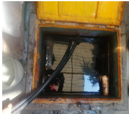
(n) Ensayo con manguera en cisterna
