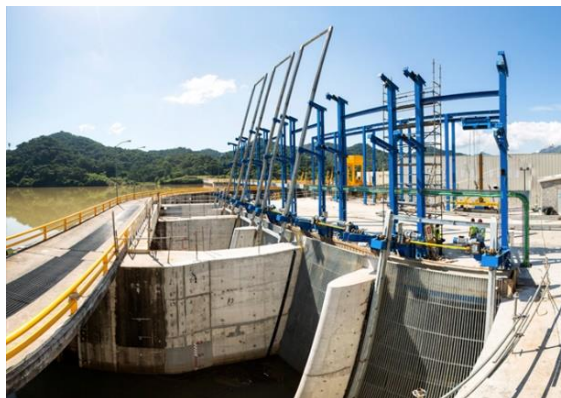
Fotografía 2 Vista en planta de la casa de máquinas donde se aprecia la subestación y los controles de compuertas y rejillas en su losa (izq). Obra de toma con rejillas y compuertas (der.). Fuente: Presa San Rafael, Nayariit
