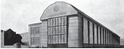
Fábrica de turbinas AEG. Arquitecto: Peter Behrens. Año: 1910. Ubicación: Berlín, Alemania. *F02.
