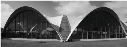
Planta embotelladora de Bacardí. Arquitecto: Félix Candela. Año:1958-1960. Ubicación: Cuautitlán Izcalli, México. *F03.
