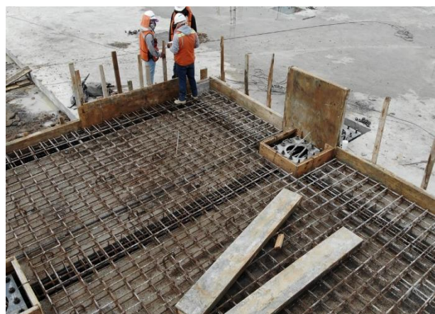
Cimbra lateral para el colado de la cimentación. Locales comerciales B. | Septiembre 2020. | Foto brindada por (Pastor, 2020).
