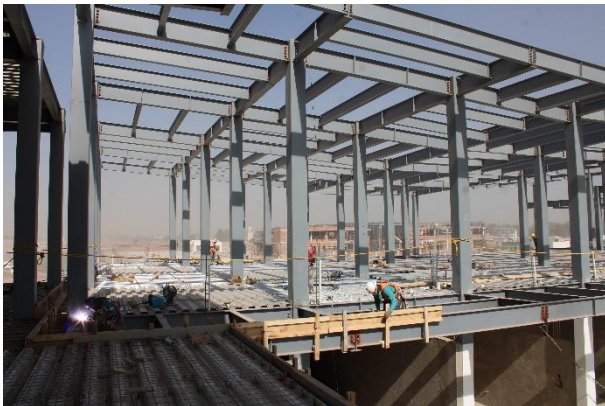
Colocado de malla electrosoldada y pernos tipo Nelson. Locales comerciales B. | Noviembre 2020. | Foto brindada por (Pastor, 2020).
