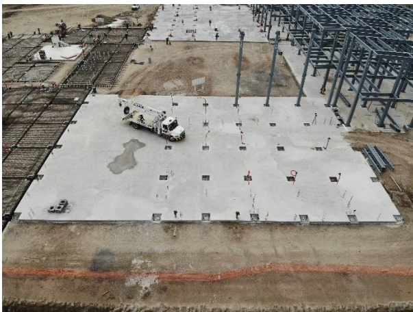
Primeras columnas en locales comerciales B. | Septiembre 2020. | Foto brindada por (Pastor, 2020).
