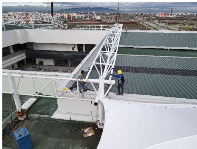
Instalación de elementos prefabricados sobre bases aisladoras. | Foto brindada por (Pastor, 2020).
