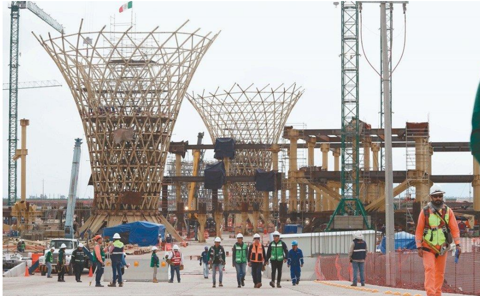
Construcción de foniles. | (El universal, 2020).
