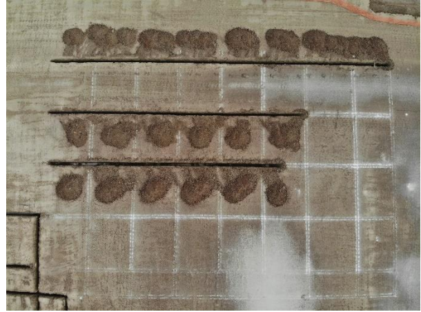
Primeras excavaciones para cimentación. Locales comerciales B. | Julio 2020. | Foto brindada por (Pastor, 2020).
