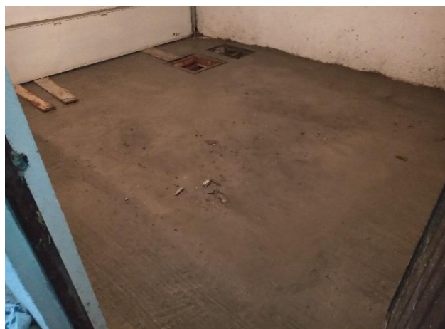
Colado de losa tapa | Febrero 2021. | Autor: César Alejandro Chavira Ramos.
