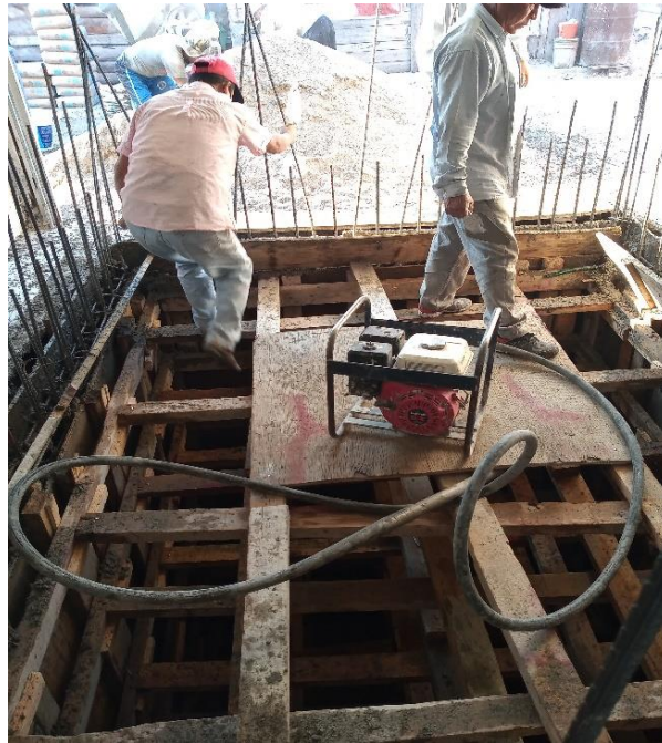
Colado monolítico de losa base y muros perimetrales. | Febrero 2021. | Autor: César Alejandro Chavira Ramos.
