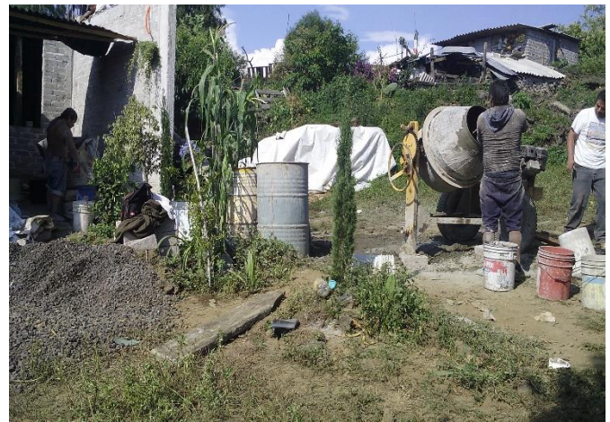
Colado de concreto para losa de primer nivel | Diciembre 2018. | Autor: César Alejandro Chavira Ramos.
