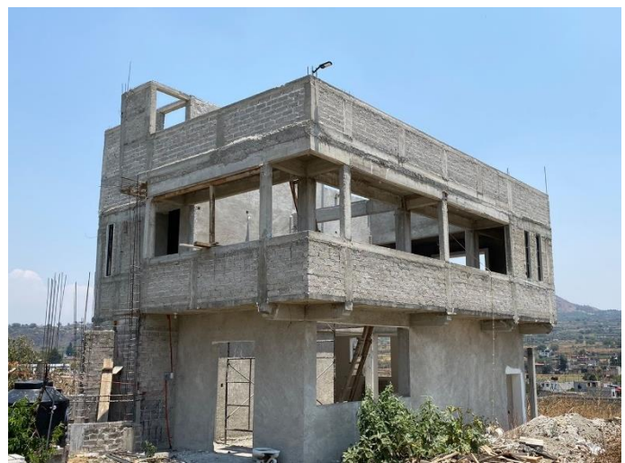
Construcción de segundo nivel. | Mayo 2022. | Autor: César Alejandro Chavira Ramos.
