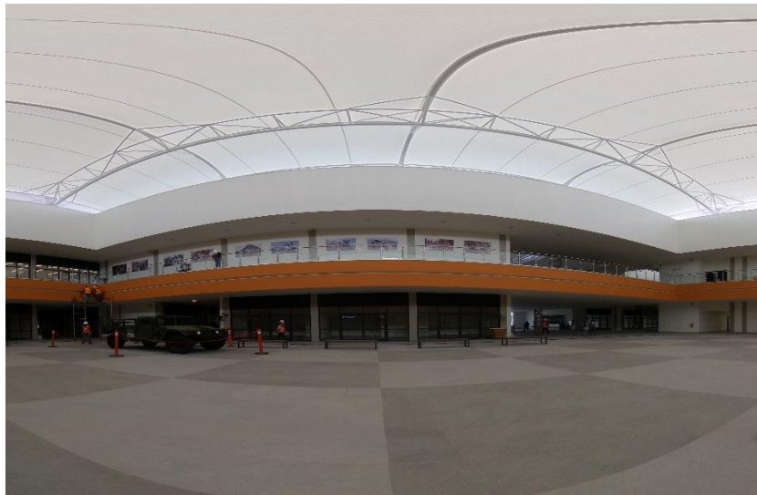
Instalación de membrana de cubierta ligera terminada. | Foto brindada por (Pastor, 2020).
