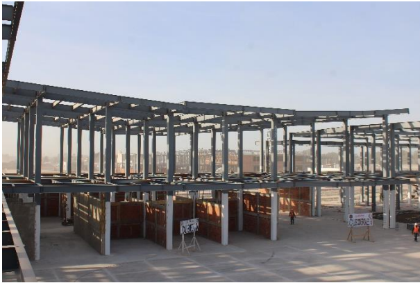
Construcción de muros divisorios de planta baja. Locales comerciales B. | Octubre 2020. | Foto brindada por (Pastor, 2020).
