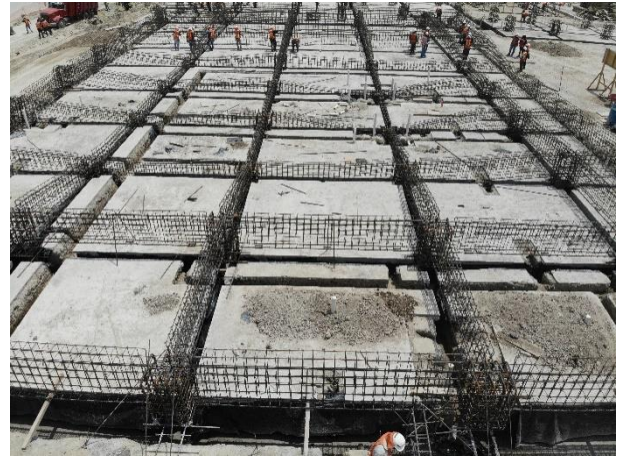
Presentación de armado de contratraves antes de ser bajadas a su posición final. Locales comerciales B. | Septiembre 2020. | Foto brindada por (Pastor, 2020).
