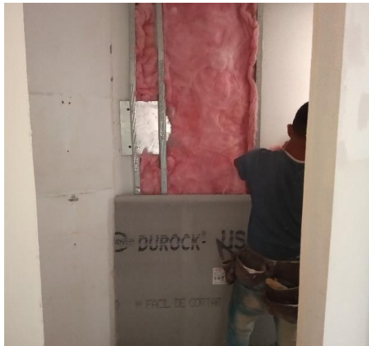
Construcción de muros con aislante acústico para cuarto de máquinas | Enero 2021. | Autor: César Alejandro Chavira Ramos.
