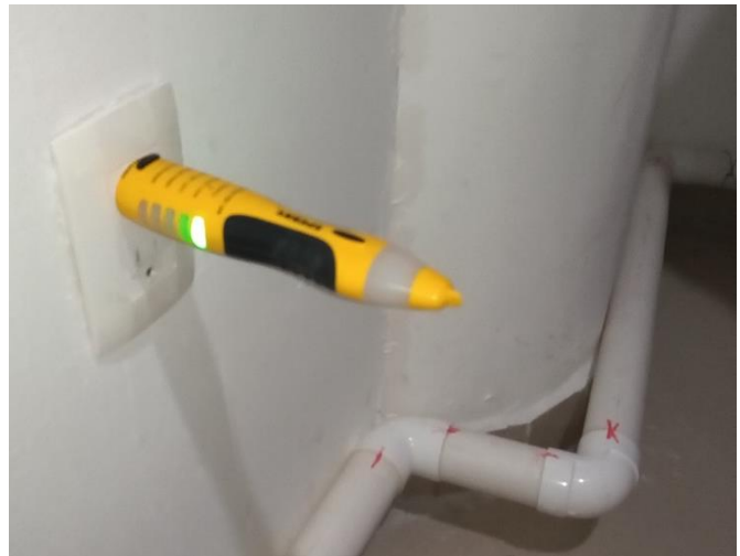
Verificación de instalaciones eléctricas. | Enero 2021. | Autor: César Alejandro Chavira Ramos.
