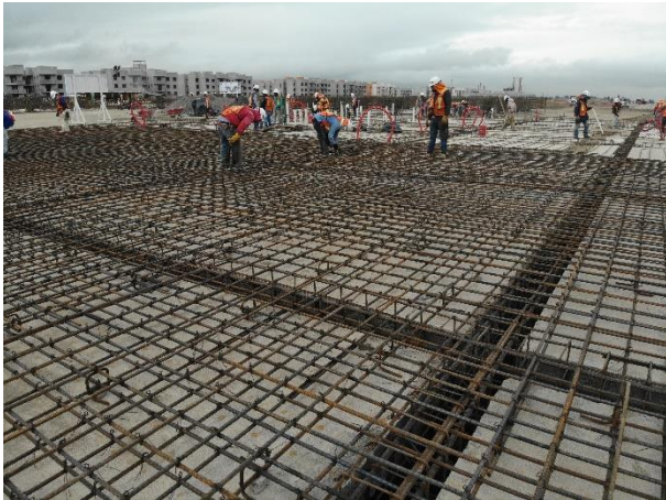
Uso de silletas para elevar el armado de varillas. Locales comerciales B. | Septiembre 2020. | Foto brindada por (Pastor, 2020).
