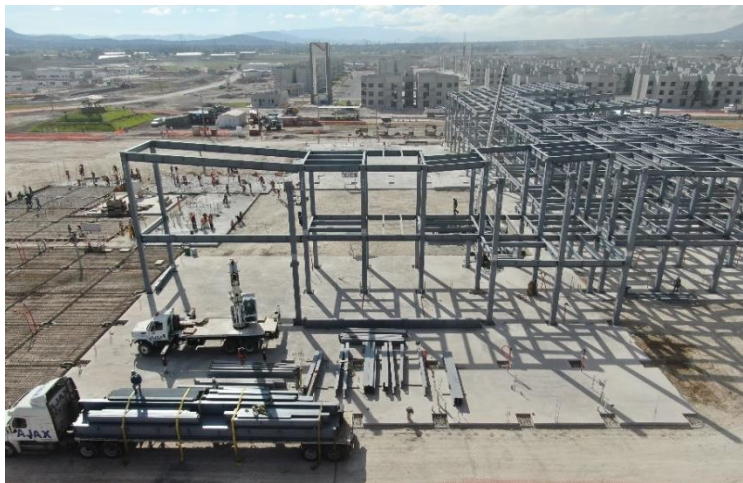
Descarga de vigas para el centro comercial militar. | Foto brindada por (Pastor, 2020).
