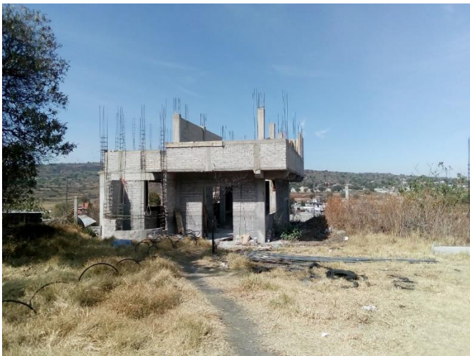
Construcción de segundo nivel. | Enero 2022. | Autor: César Alejandro Chavira Ramos.
