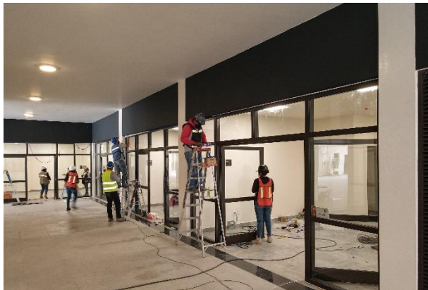
Instalación de cancelería. Locales comerciales B. Febrero 2021. | Foto brindada por (Pastor, 2020).
