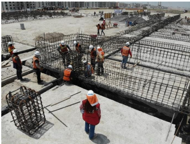
Armado de dados de cimentación. Locales comerciales B. | Septiembre 2020. | Foto brindada por (Pastor, 2020).
