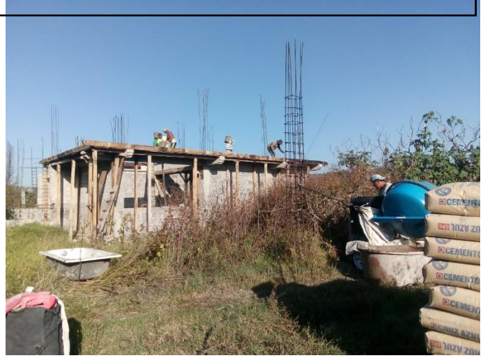
Colado de losa primer nivel | Diciembre 2020. | Autor: César Alejandro Chavira Ramos.
