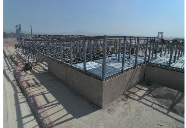
Aplanado de muros exteriores en planta baja. Instalación de losacero en primer nivel. Locales comerciales B. | Noviembre 2020. | Foto brindada por (Pastor, 2020).
