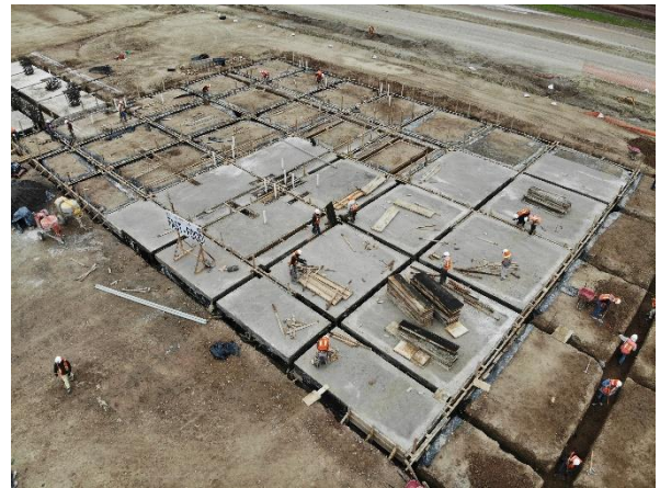
Colado de plantillas de concreto pobre en horizontal y vertical con grosor de 5cm. Locales comerciales B. | Agosto 2020. | Foto brindada por (Pastor, 2020).
