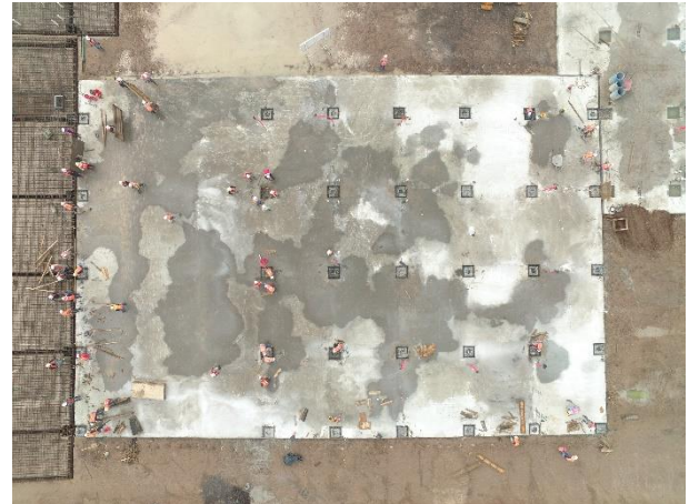
Curado de cimentación. Locales comerciales B. | Septiembre 2020. | Foto brindada por (Pastor, 2020).
