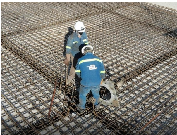
Colocación de anclas y placas para recibir las columnas de acero. Locales comerciales B. | Septiembre 2020. | Foto brindada por (Pastor, 2020).
