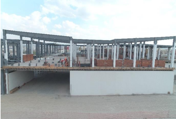
Construcción de muros divisorios de primer nivel. Locales comerciales B. | Diciembre 2020. | Foto brindada por (Pastor, 2020).
