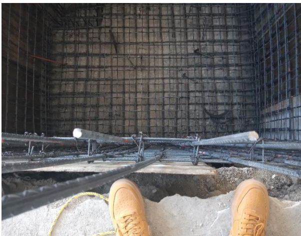
Armado de varillas. | Febrero 2021. | Autor: César Alejandro Chavira Ramos.
