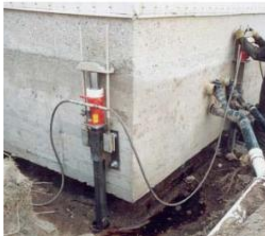
Recalce de cimentación con micropilotes. Fig. 1.8
