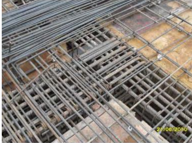
Fig. 2.15. Intersección de las armaduras de dos vigas, con el acero bastante tupido en la zona de encuentro. Nótese el acero longitudinal pegado al encofrado lateral.
