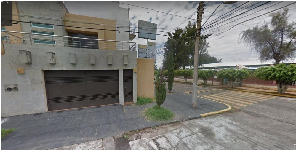
Fotografía 3.4. contra esquina con calle Simón Bolívar y calle Colombia, de la colonia Los Ángeles.
