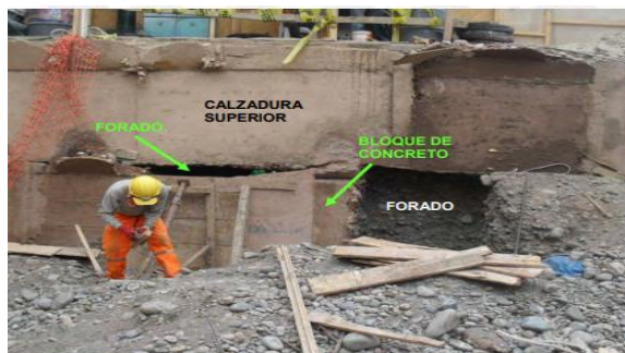
Fig. 1.18: Trabajador encofrando dos forados para fabricar bloques de calzadura (nivel inferior), a los cuales solo los separa un pequeño bloque de concreto. (PUCP; 2013: 11)
