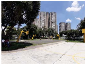
12. Vista hacia torres de 16 niveles.
