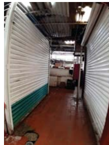
16. Pasillos. Cubierta de lámina con paneles traslúcidos.
