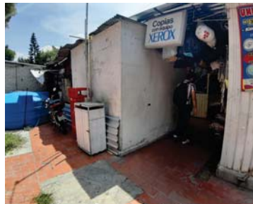
19. Acceso norte. Tinaco para cisterna a la vista de todos.
