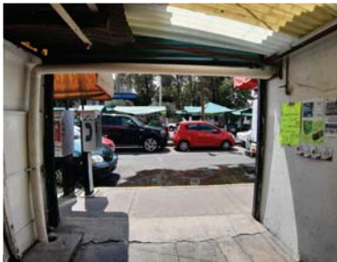
14. Acceso Poniente. Se producen encharcamientos sobre Av. Central.
