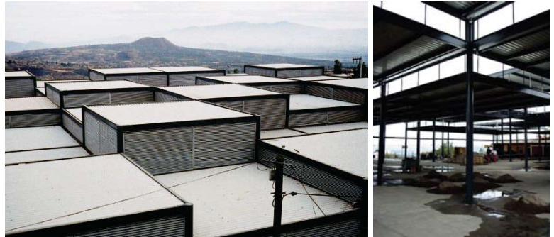
Imágenes Volumetría de Cubierta y Estructura. (Fotógrafo Luis Gordo)
