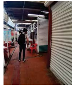
17. Pasillos y Locales. Acabados en piso se encuentran reparados y desiguales.
