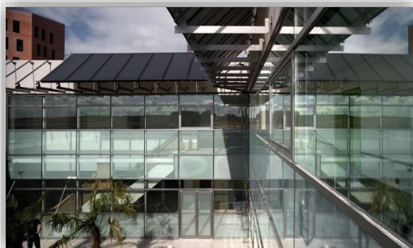
Fachada interior con muro cortina
