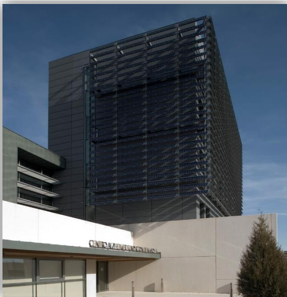
Fachada del centro de investigación con paneles solares
