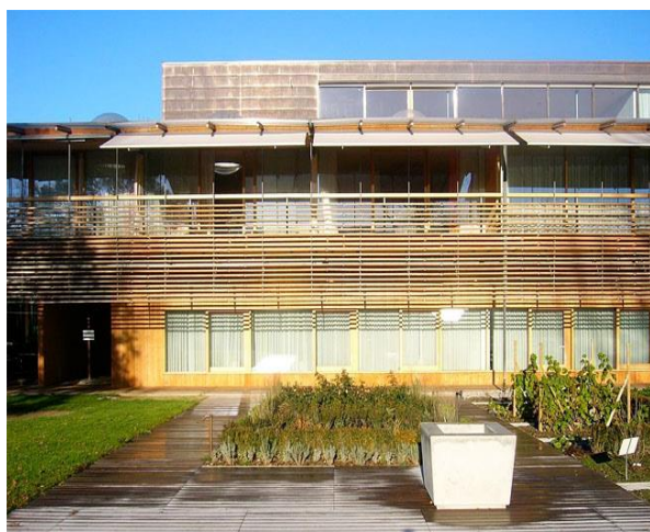
Fachada de proyecto
