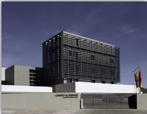
Fachada de acceso principal y edificio de Investigación
