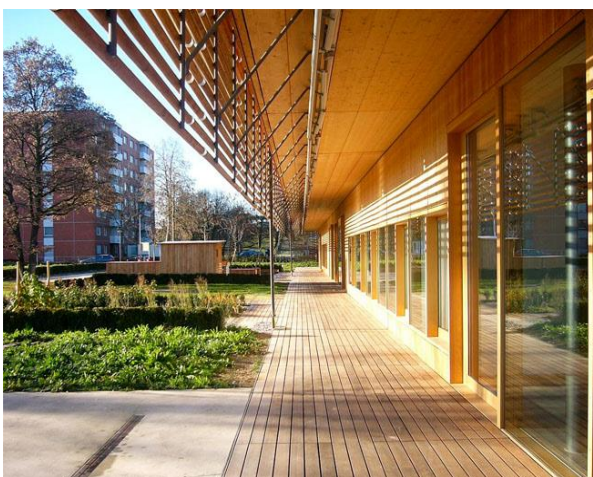
Paseo cubierto de madera
