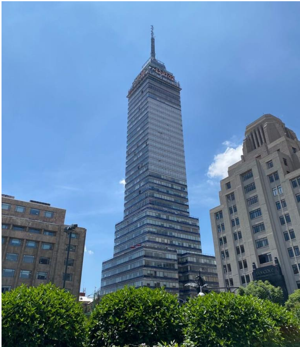
Imagen 2.1.8. Torre Latinoamericana. Tiene 182 metros de altura y consta de 44 pisos. El proyecto arquitectónico corresponde a Augusto H. Álvarez; mientras que, la estructura metálica, fue diseñada por Leonardo Zeevaert y Nathan M. Neumark . Debajo de la torre se colocó una losa de cimentación, así como 361 pilotes. Otro punto a destacar de esta tecnología antisísmica está en los tres sótanos totalmente huecos que actúan como una especie de línea de flotación de un barco. (Gálvez, 2021) Foto del autor
