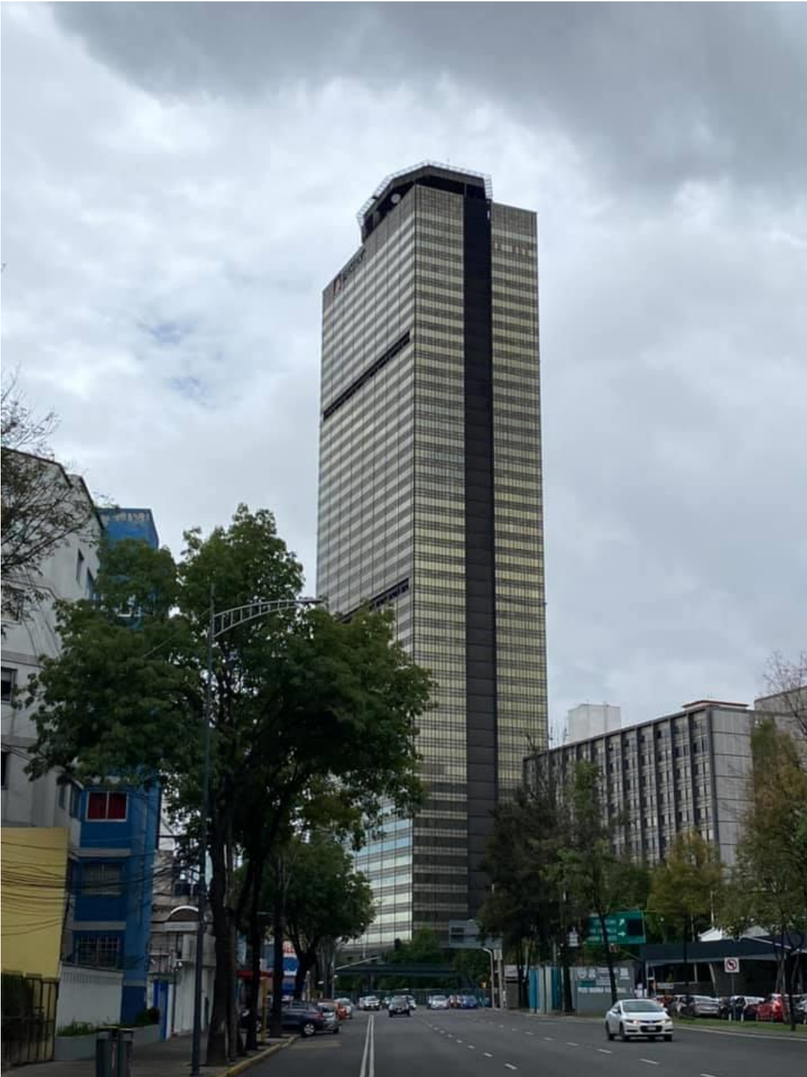
Imagen 2.1.10. Torre de Pemex. Fue diseñada por Pedro Moctezuma. Mide 214 metros de altura. Se apoya en 164 pilas de concreto y acero que penetran a una profundidad de 32 metros. En su momento, fue el edificio más alto del país y dos años, de América Latina. Se le considera uno de los rascacielos más resistentes y seguros del mundo (La torre de Pemex, 2018). Foto del autor
