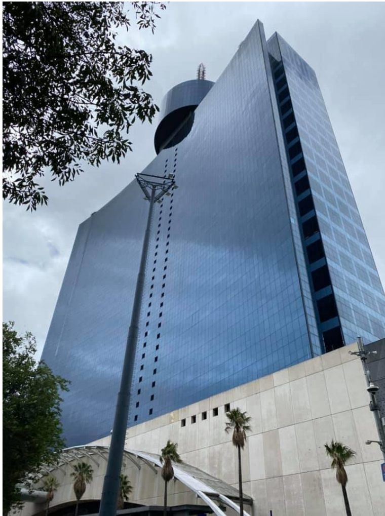
Imagen 2.1.9. Word trade Center . Hotel en un principio, debido a retrasos en la construcción se replanteó el proyecto para convertirlo en un Centro Internacional de Negocios. Tiene 50 pisos, estructura de concreto armado con 34 mil metros cúbicos de concreto, 28 mil toneladas de acero estructural y 56 amortiguadores sísmicos (Diario de México, 2019). Fue el edificio más alto de la ciudad en 1994. Foto del autor
