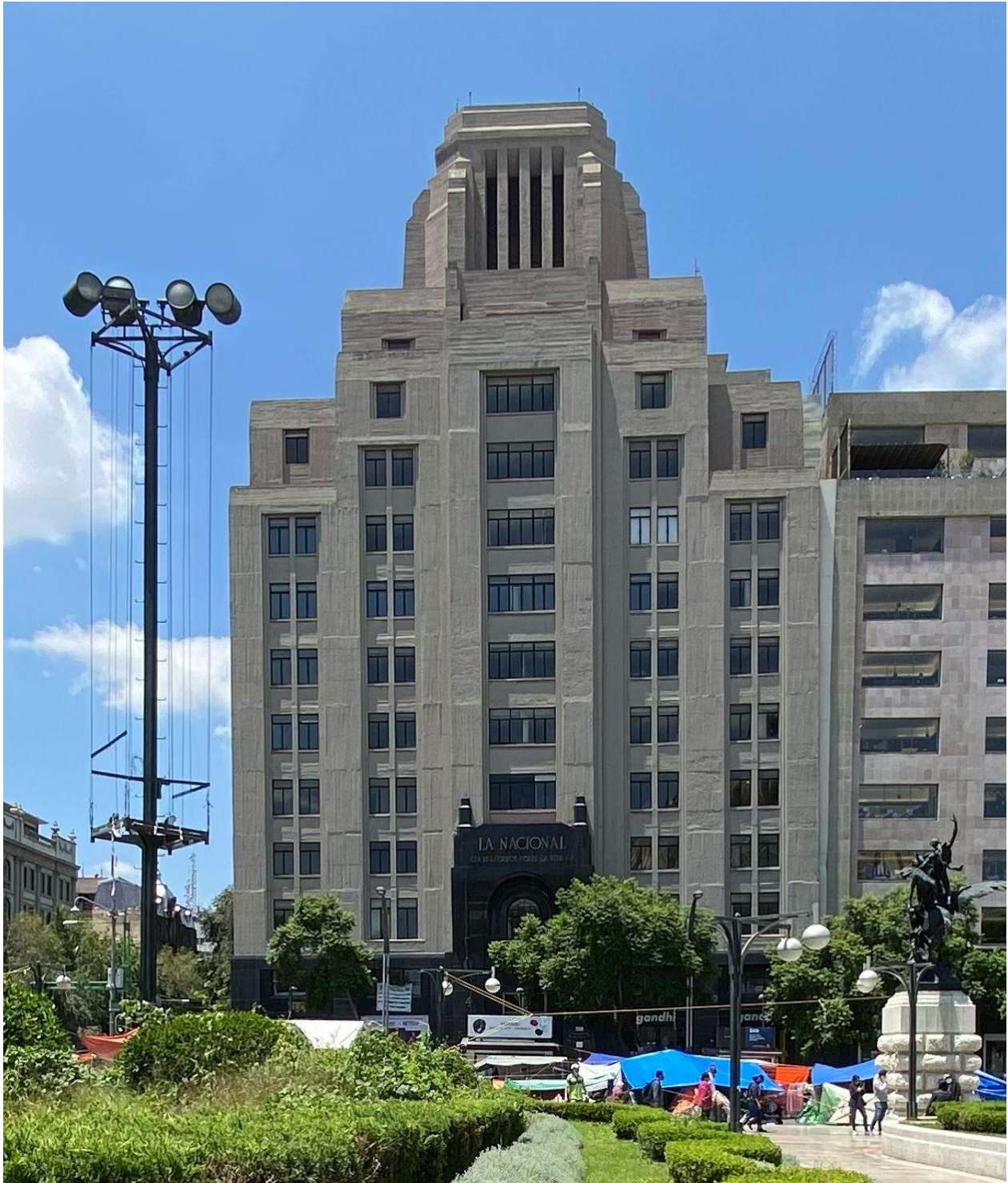
Imagen 2.1.7. Edificio La Nacional. Diseñado por Manuel Ortiz Monasterio entre 1929 y 1932, con el reto de construir un edificio alto para la época (fue el primero de más de 13 niveles) con el consabido riesgo sísmico. Fue el primer edificio en contar con un estudio previo de ingeniería antisísmica. Ha soportado más de 10 movimientos telúricos de consideración, sin haberse comprometido en ningún caso la estructura. La solución estructural, diseñada por los hermanos Bernardo y José Luis Calderón, fue a base de concreto armado y acero, con una cimentación mixta, con losa de concreto pretensado y alrededor de 100 pilotes, hincados a una profundidad de 55 metros. En 1934 fue el inmueble más alto de la capital. Foto del autor.
