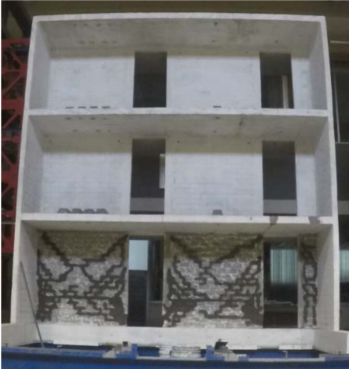
Figura 7. Muros reparados mediante rajuelas, sustitución de piezas, y remplazo de concreto en castillos
