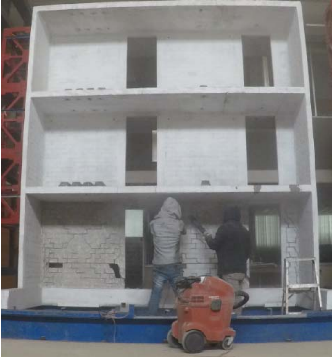
Figura 6. Preparación de superficie de muros para recibir encamisado
