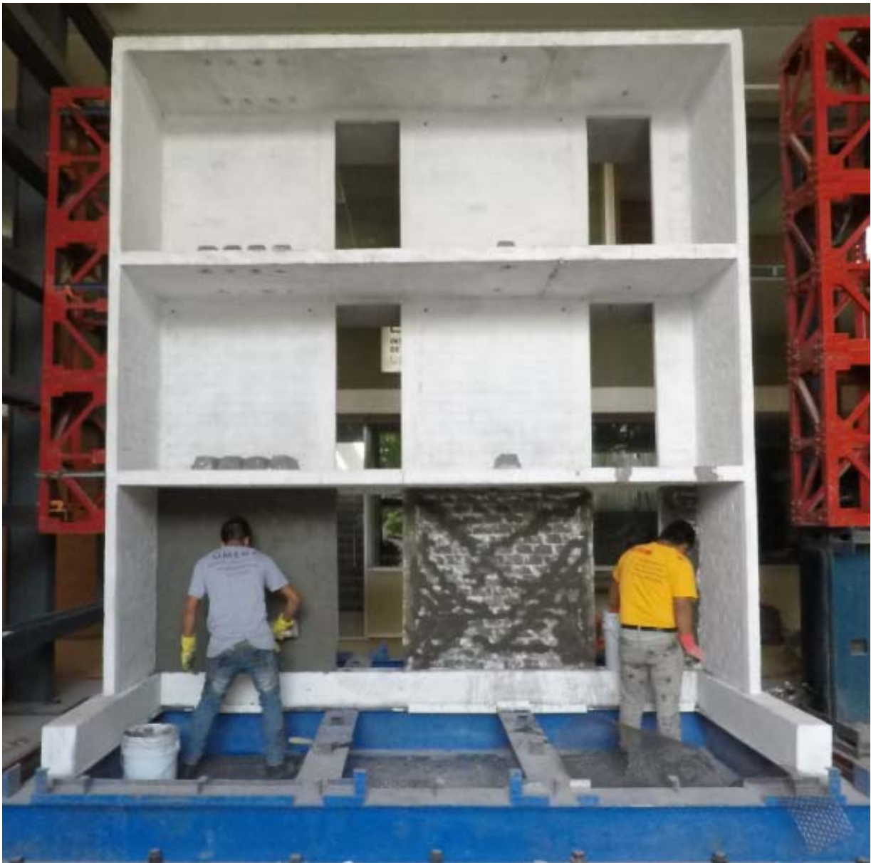
Figura 10. Aplicación de la segunda capa de mortero en muro
