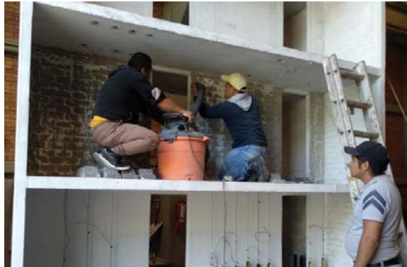
a) Retiro de recubrimientos
