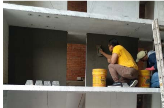
b) Aplicación de la primera capa de mortero
