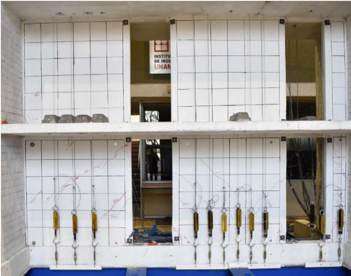
Figura 41. Modo de falla del modelo rehabilitado
