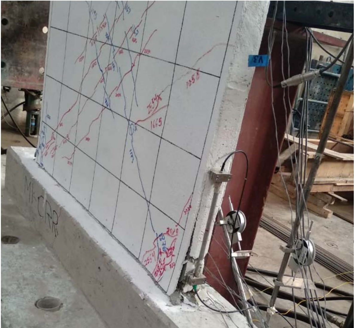
Figura 35. Desprendimiento del encamisado en modelo M1-crR
