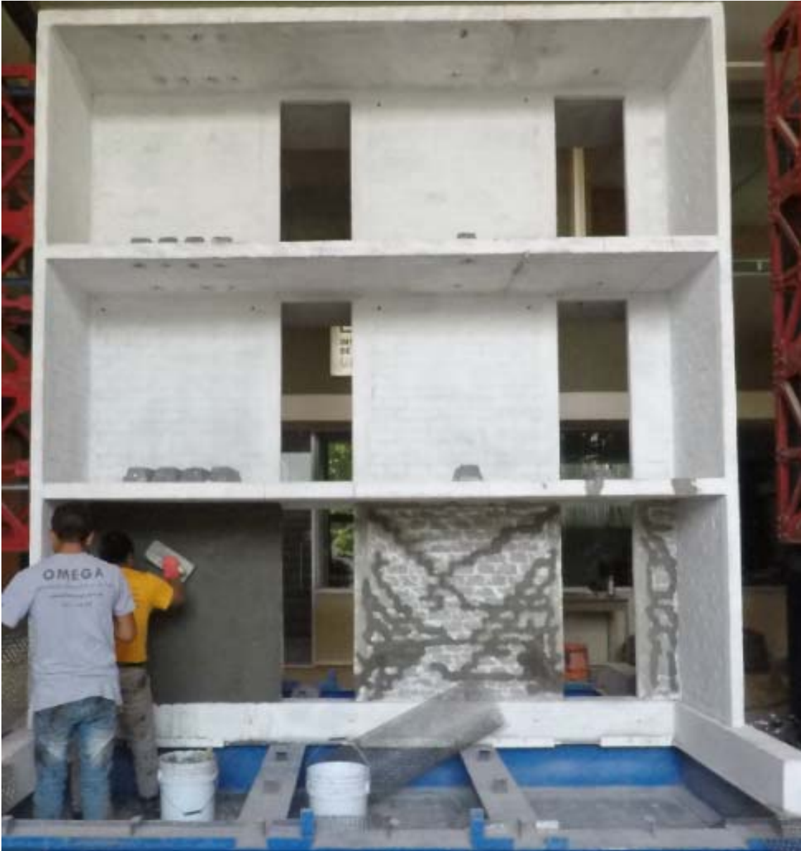
Figura 8. Aplicación de la primera capa de mortero en muro
