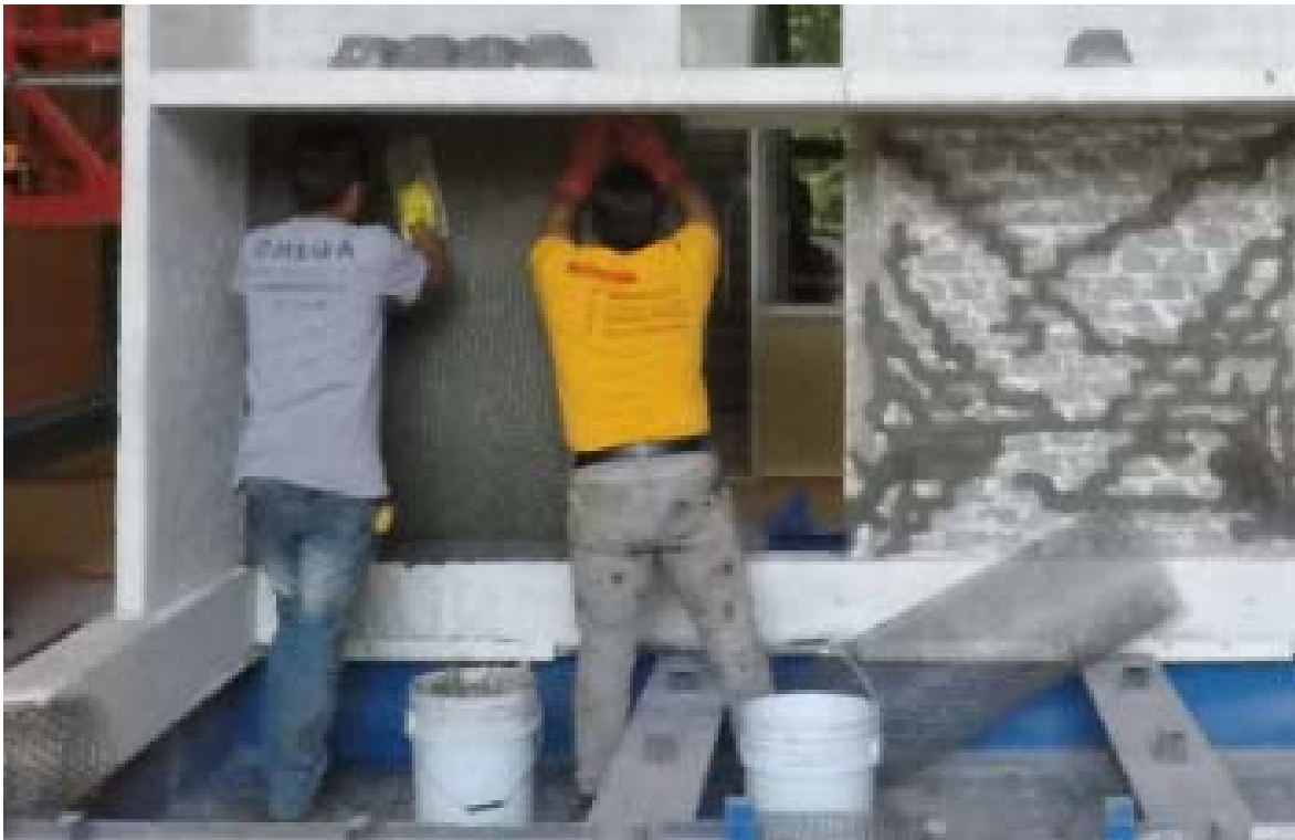
Figura 9. Colocación de malla de fibra de vidrio en muro
