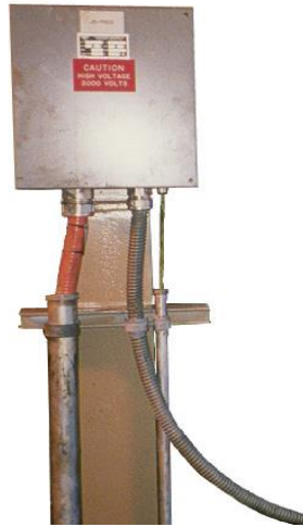
Figura 25.- Caja de Venteo. Fuente: Extraído de [17]
