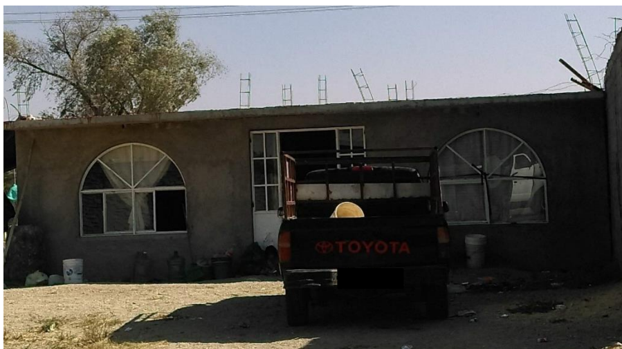
Ilustración 31 Casa en obra negra donde se alojan jornaleros en Barretos
