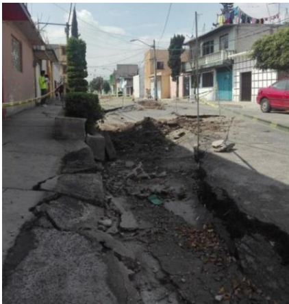
Figura 2.21. Izquierda. Calle Liborio Crespo dañada por activación de fracturamiento a causa del sismo de 2017. Figura 2.22. Derecha. Calle Circunvalación en Santa María Aztahuacán afectada por la activación de una fractura.
