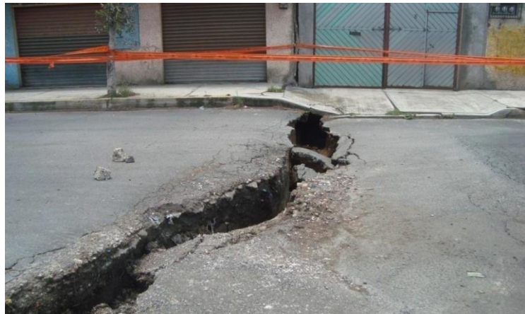
Figura 2.21. Izquierda. Calle Liborio Crespo dañada por activación de fracturamiento a causa del sismo de 2017. Figura 2.22. Derecha. Calle Circunvalación en Santa María Aztahuacán afectada por la activación de una fractura.
