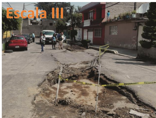
Figura 3.4. Ejemplo de cada una de las escalas de intensidad del fracturamiento en vialidades: Escala I. Maximiliano Mariles, Jacarandas, Escala II. Calle 63, U.H. Santa Cruz Meyehualco, Escala III. Liborio Crespo, Santa Martha Acatitla Sur, Escala IV. Pintapan, U.H. Cananea.
