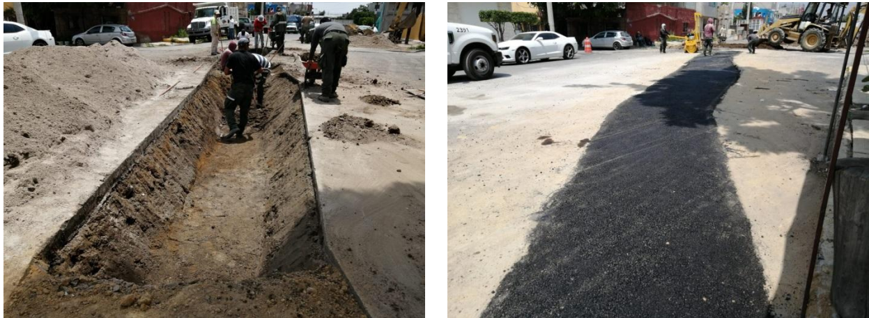
Figura 3.9 Izquierda. Construcción del cajón de arena disipador de deformaciones en fractura de la calle 19 entre Av. 4 y Av. 6, Col. U.H. Santa Cruz Meyehualco. Derecha. Estado final de la intervención con la colocación de la carpeta asfáltica.
