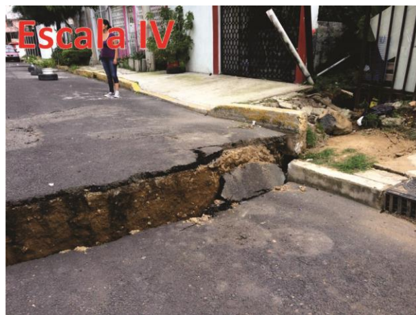
Figura 3.4. Ejemplo de cada una de las escalas de intensidad del fracturamiento en vialidades: Escala I. Maximiliano Mariles, Jacarandas, Escala II. Calle 63, U.H. Santa Cruz Meyehualco, Escala III. Liborio Crespo, Santa Martha Acatitla Sur, Escala IV. Pintapan, U.H. Cananea.
