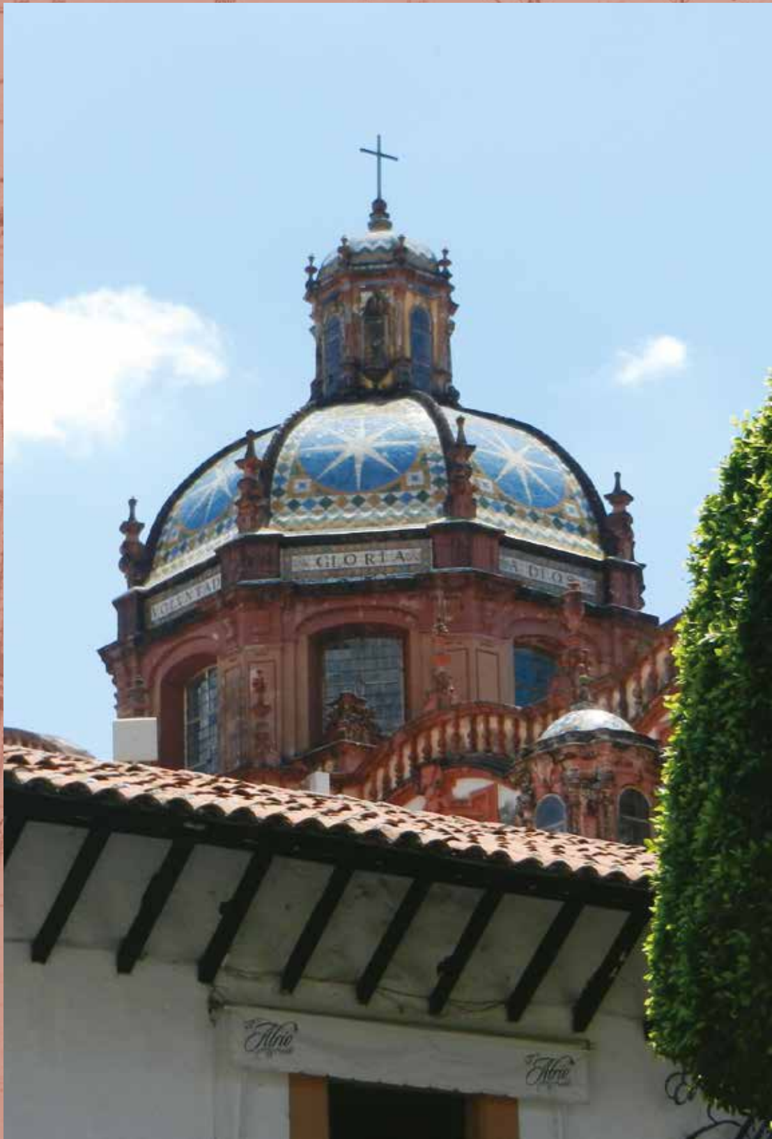
Cúpula en Taxco de Alarcón, Guerrero. Fotografía: Pablo Trujillo, 2015.
