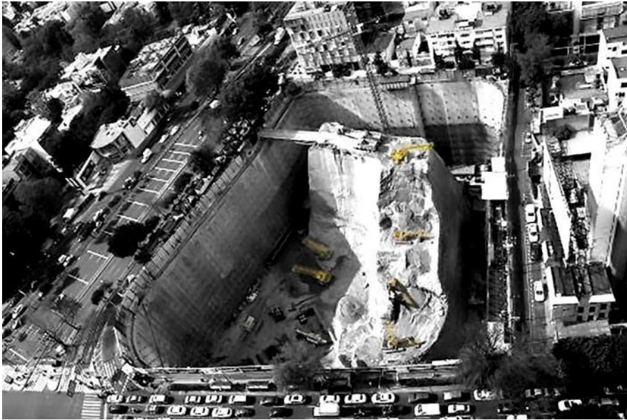
Fig. 2.1 Fotografía aérea tomada durante el proceso de excavación de Torre Manacar.
