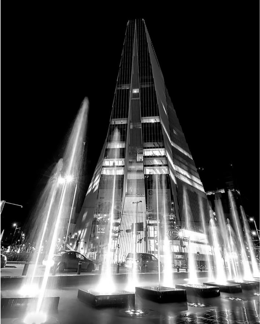
Fig. 1.8. Torre Manacar, tomada desde avenida de los Insurgentes sur en su intersección con avenida Río Churubusco, en la que se exalta su forma piramidal y se observa el empleo del agua como elemento escenográfico.
