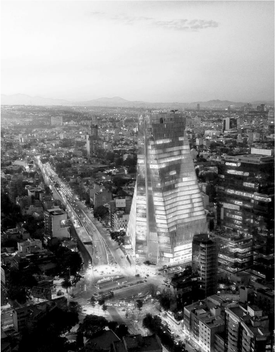
Fig. 1.1 Vista panorámica de Torre Manacar, tomada en sentido oriente poniente, en la que se observa como sobresale notoriamente de su entorno, tanto en dimensiones, materialidad y forma.
