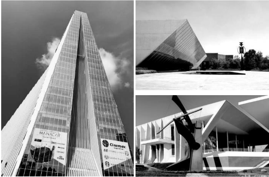
Fig. 3.8 (izq.). Fachada inclinada de Torre Manacar; Fig. 3.9 (arriba dcha.). Fachada inclinada de MUAC; Fig. 3.10 (abajo dcha.). Fachada inclinada del Querétaro Centro de Congresos.
