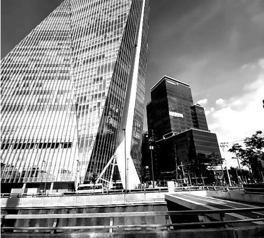
Fig. 2.14 Fachada poniente de Torre Manacar, en la que se observa la gran cantidad de persianas
