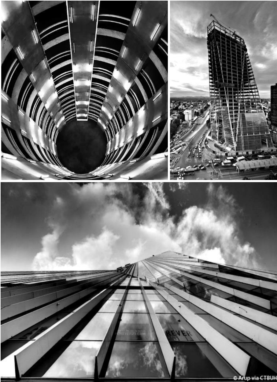
Fig. 2.3 (arriba izq.) Núcleo de rampas del estacionamiento subterráneo de Torre Manacar. Fig.2.4 (arriba dcha.) Vista aérea de Manacar, durante su construcción.; Fig. 2.5. (abajo) Detalle del curtain Wall y los parasoles de aluminio en fachada de Torre Manacar
