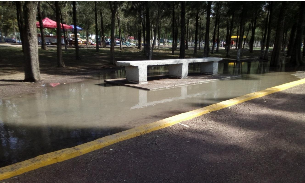
Imagen 12. Zonas de uso común, inundadas.
