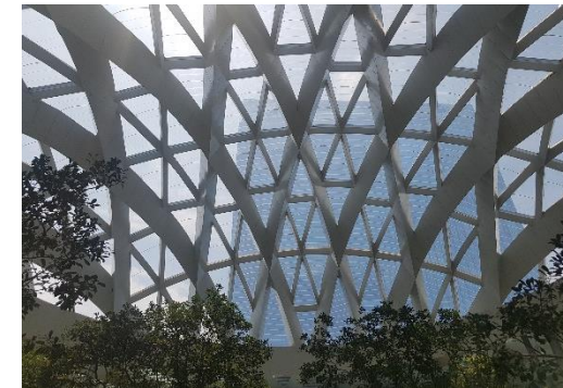
Cubierta de acero y vidrio para cubrir grandes claros. Parque Central Toreo
