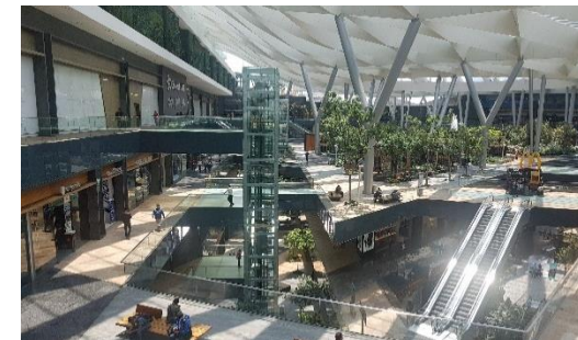
Escaleras Eléctricas y Ascensores Parque Central Toreo
